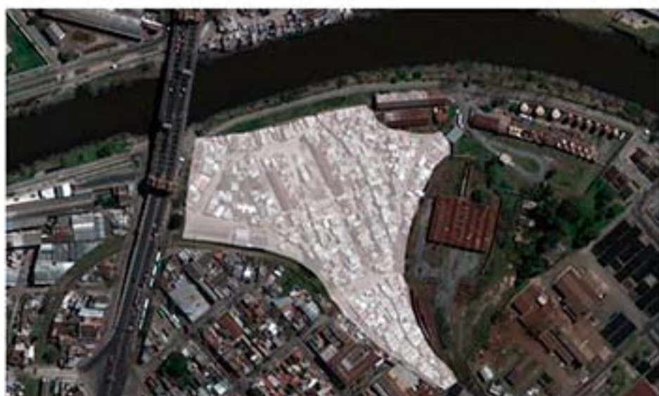
ZOOM - Asentamiento Puente Alsina a Relocalizar
