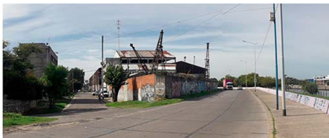
DESPUÉS: 14 de febrero de 2025 Vista desde: Camino de Sirga hacia Cuenca Alta
