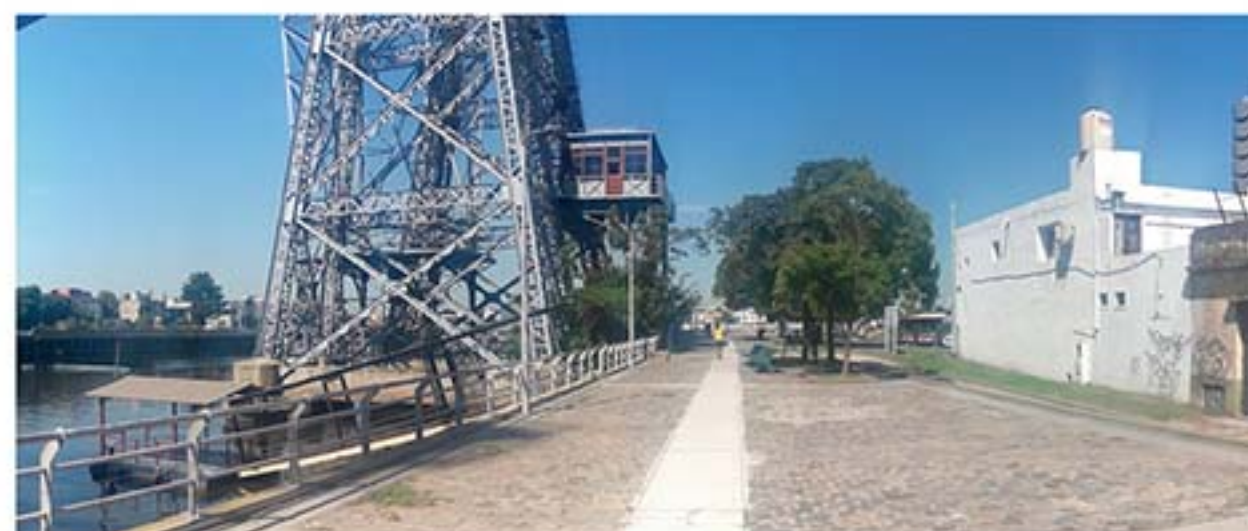
DESPUÉS: 21 de febrero de 2025 Vista desde: Camino de Sirga hacia Cuenca Alta
