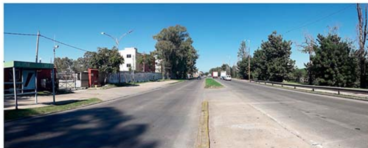
Archivo: 3 de abril de 2025 Construcción de viviendas en el ex-predio Vialidad Nacional Vista desde: Camino de Sirga hacia Cuenca Alta
