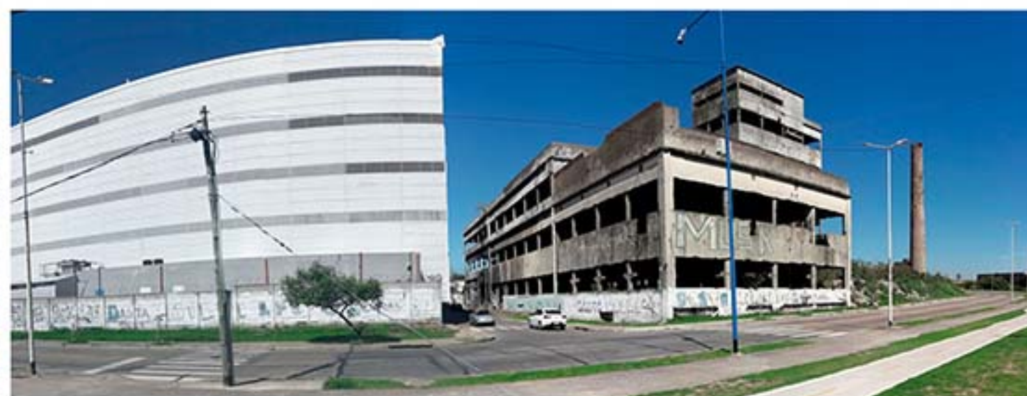
DESPUÉS: 17 de febrero de 2025 Vista desde: Camino de Sirga hacia Cuenca Alta
