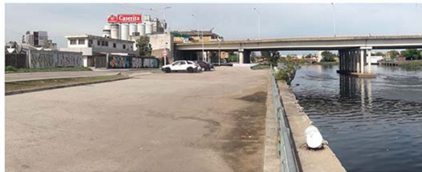
DESPUÉS: 14 de febrero de 2025 Vista desde: Camino de Sirga hacia Cuenca Alta
