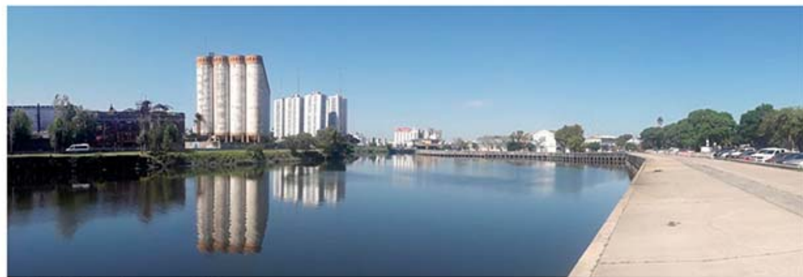
DESPUÉS: 21 de febrero de 2025 Vista desde: Camino de Sirga hacia Cuenca Alta
