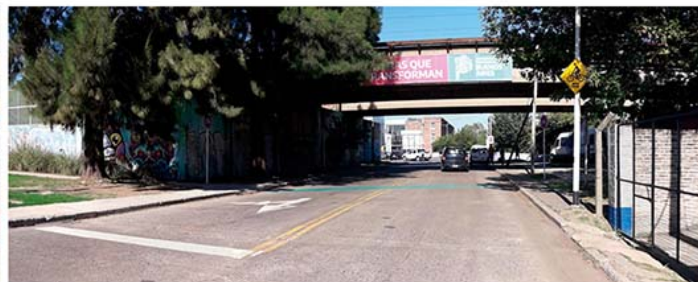
DESPUÉS: 17 de febrero de 2025 Vista: bajo Puente Bosch hacia Cuenca Alta
