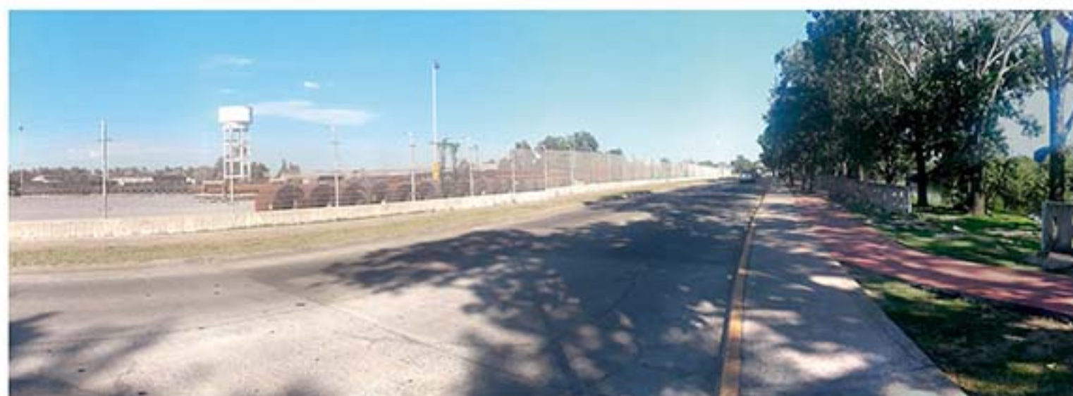
DESPUÉS: 21 de febrero de 2025 Vista desde: Camino de Sirga hacia Cuenca Alta
