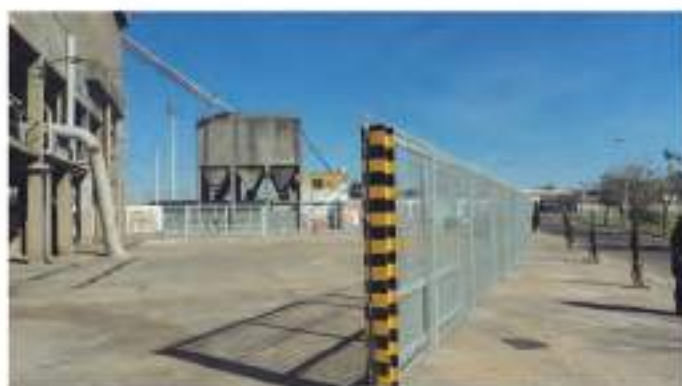
ANTES: 5 de Diciembre de 2010 Vista desde: Camino de Sirga hacia Cuenca Alta
