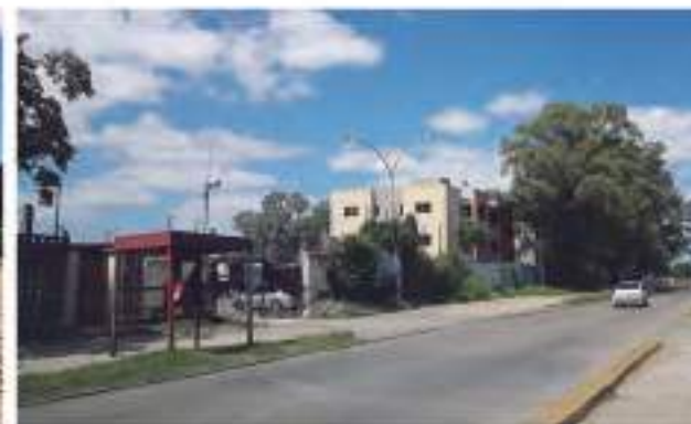
Archivo: 12 de Febrero de 2019 Construcción de viviendas en el ex-predio Vialidad Nacional Vista desde: Camino de Sirga hacia Cuenca Alta
