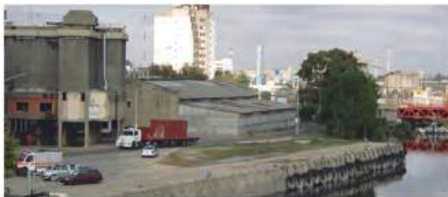
ANTES: 26 de Junio de 2011 Vista desde: Nuevo Puente Pueyrredón hacia Cuenca Alta
