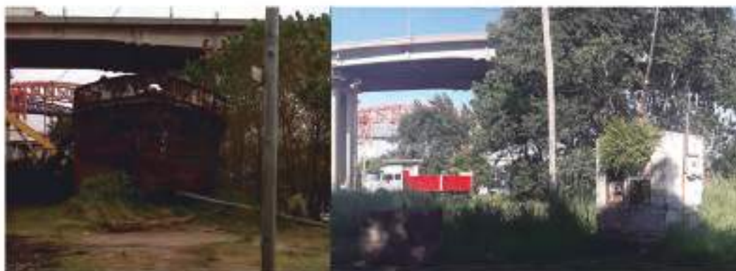
ANTES: 30 de Mayo de 2011 Vista hacia: Puente Traslador hacia C. Alta
