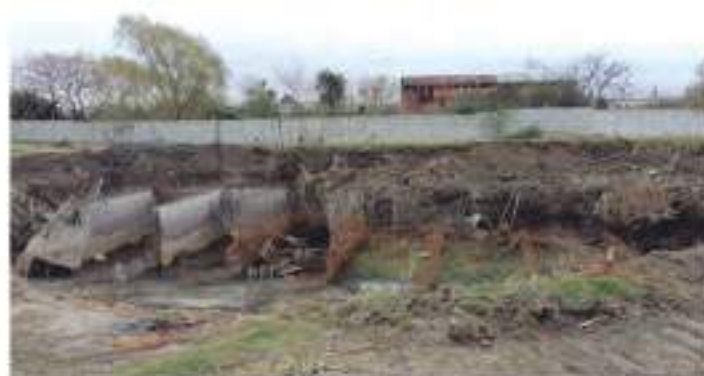
ANTES: 1 de Julio de 2011 Vista desde: Camino de Sirga hacia la C.A.B.A.
