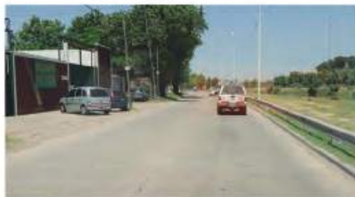
ANTES: 3 de Diciembre de 2010 Vista desde: Camino de Sirga hacia Cuenca Alta
