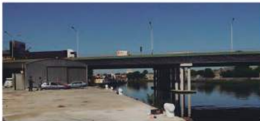
ANTES: 5 de Diciembre de 2010 Vista desde: Camino de Sirga hacia Cuenca Alta
