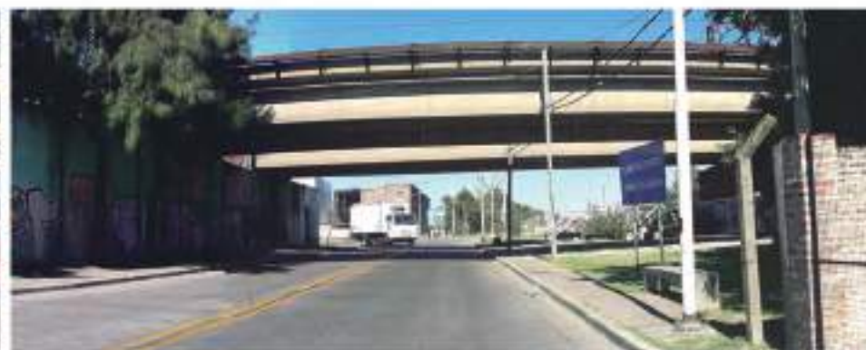
DESPUÉS: 5 de Febrero de 2019 Vista: bajo Puente Bosch hacia Cuenca Alta
