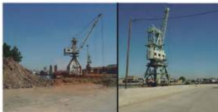
ANTES: 10 de Octubre de 2010 Vista desde: Camino de Sirga hacia Cuenca Alta
