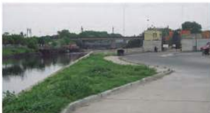
ANTES: 30 de Octubre de 2009 Vista desde: Camino de Sirga hacia Cuenca Alta
