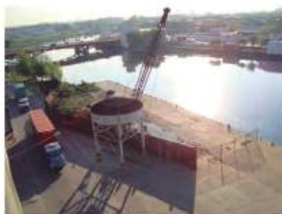
ANTES: 18 de Octubre de 2010 Vista desde: Camino de Sirga hacia Cuenca Alta
