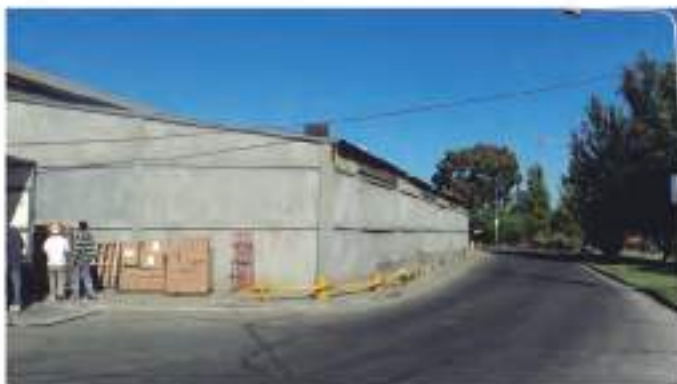
ANTES: 17 de Mayo de 2011 Vista desde: Camino de Sirga hacia Cuenca Alta
