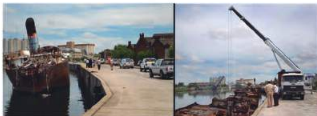
ANTES: 30 de Mayo de 2011 Vista desde: Camino de Sirga hacia Cuenca Alta
