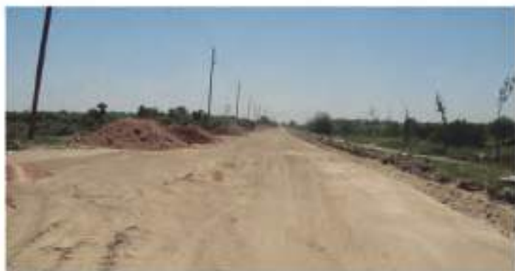
ANTES: 27 de Octubre de 2011 Vista desde: Camino de Sirga hacia Cuenca Alta
