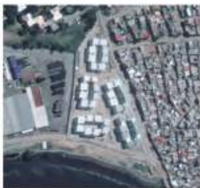
DESPUÉS: 24 de Noviembre de 2018 Imagen satelital de Google Earth
