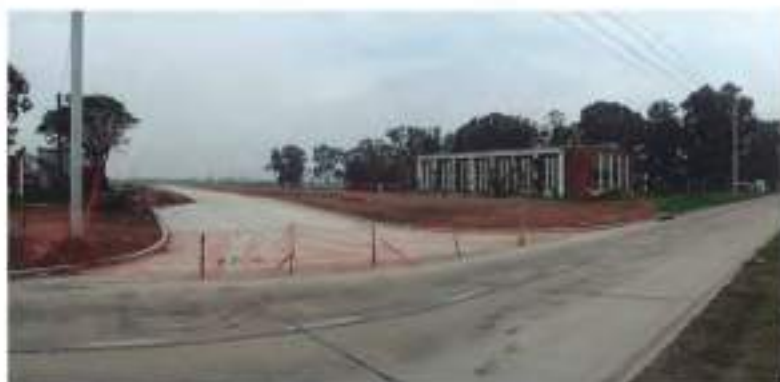
ANTES: 28 de Mayo de 2012 Vista desde: Camino de Sirga hacia Cuenca Alta
