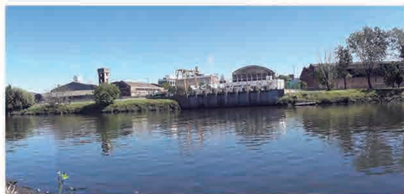
DESPUÉS: 2 de Febrero de 2019 Vista desde: margen de enfrente (Avellaneda)
