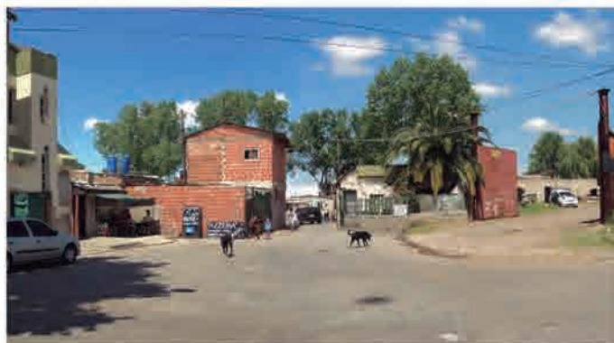
ANTES: 24 de Octubre de 2011 Vista desde: la calle Magaldi hacia el Camino de Sirga
