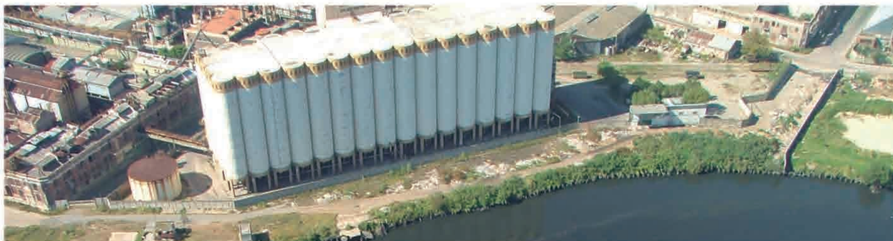
SITIO DE DESGUACE - DESPUÉS (VISTA AEREA)
