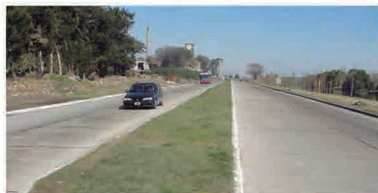
ANTES: 22 de Julio de 2010 Vista desde: Camino de Sirga hacia Cuenca Alta
