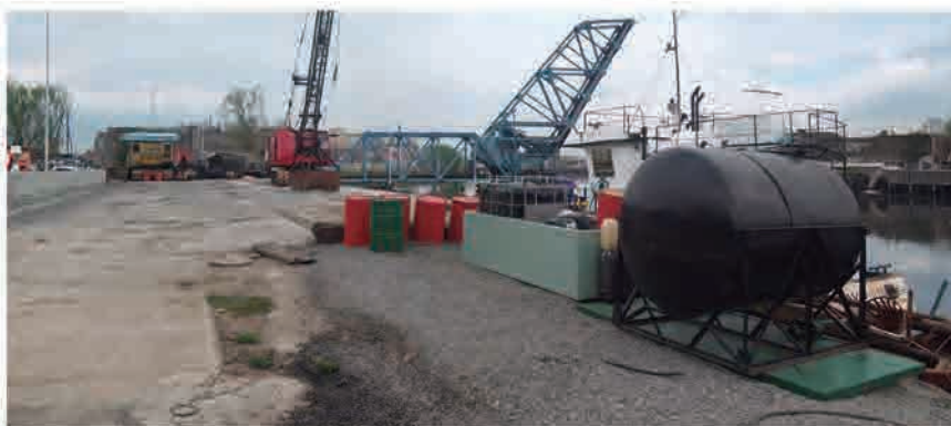
ANTES: 15 de Febrero de 2008 Vista desde: Camino de Sirga hacia Cuenca Alta
