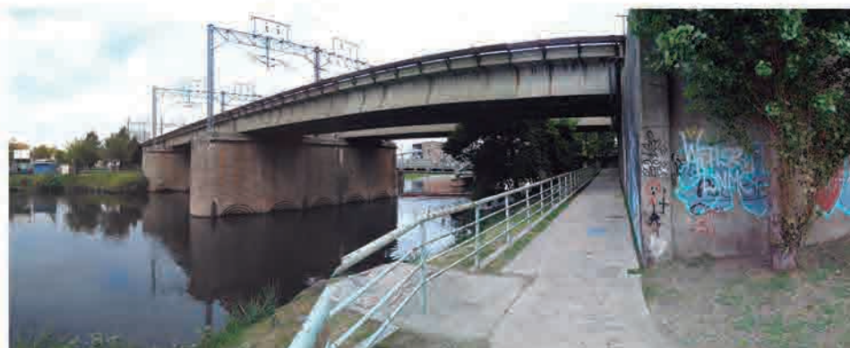
DESPUÉS - Archivo ACUMAR - 18 de Abril de 2017 Vista desde: Camino de Sirga
