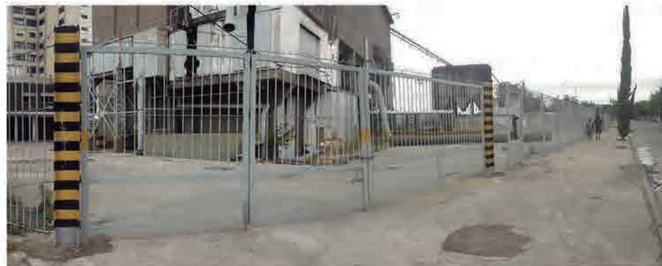
DESPUÉS: 30 de Enero de 2019 Vista desde: Camino de Sirga hacia Cuenca Alta
