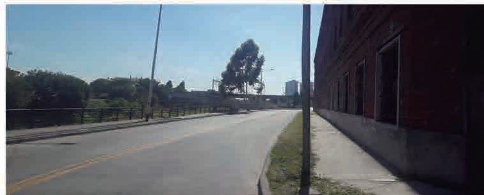
DESPUÉS; 8 de Febrero de 2019 Vista desde: Camino de Sirga hacia Desembocadura
