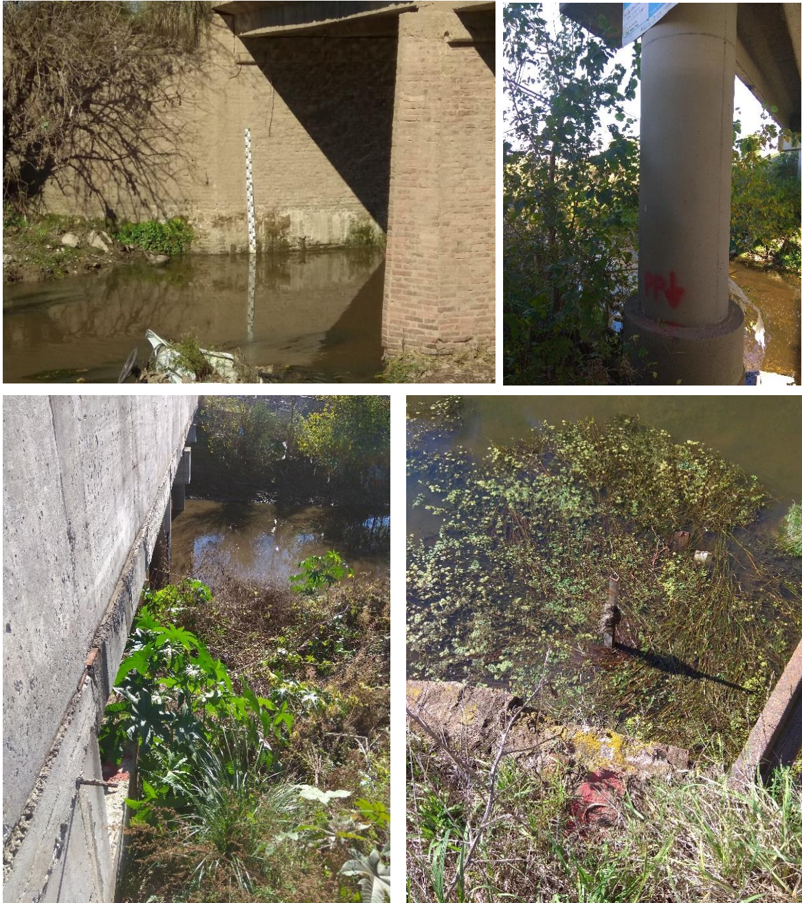
Fotos 3 a 6. Relevamiento de accesos a las EM y estado de distintos elementos de las estaciones hidrométricas en la red de monitoreo de agua superficial de ACUMAR. Escalas, puntos fijos (PF), puntos de paso (PP).
