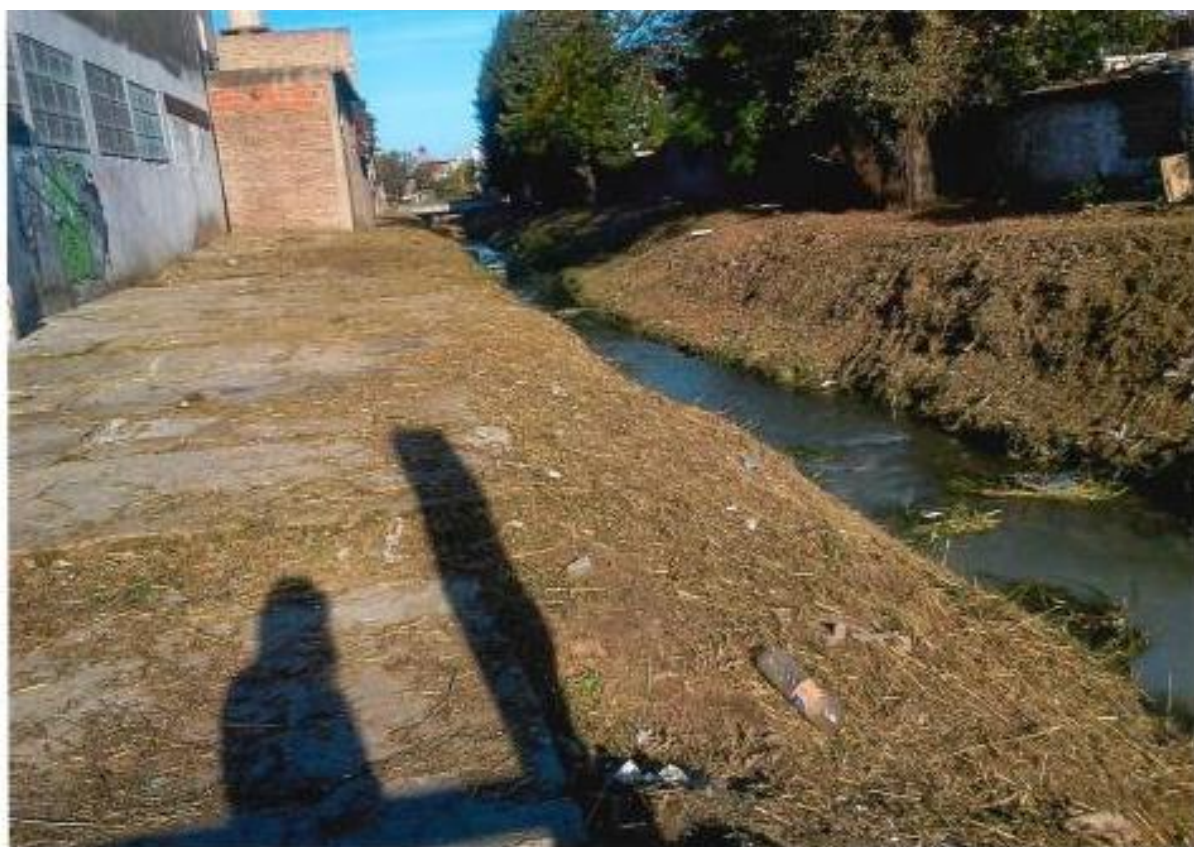
Finalización de la etapa de limpieza.
