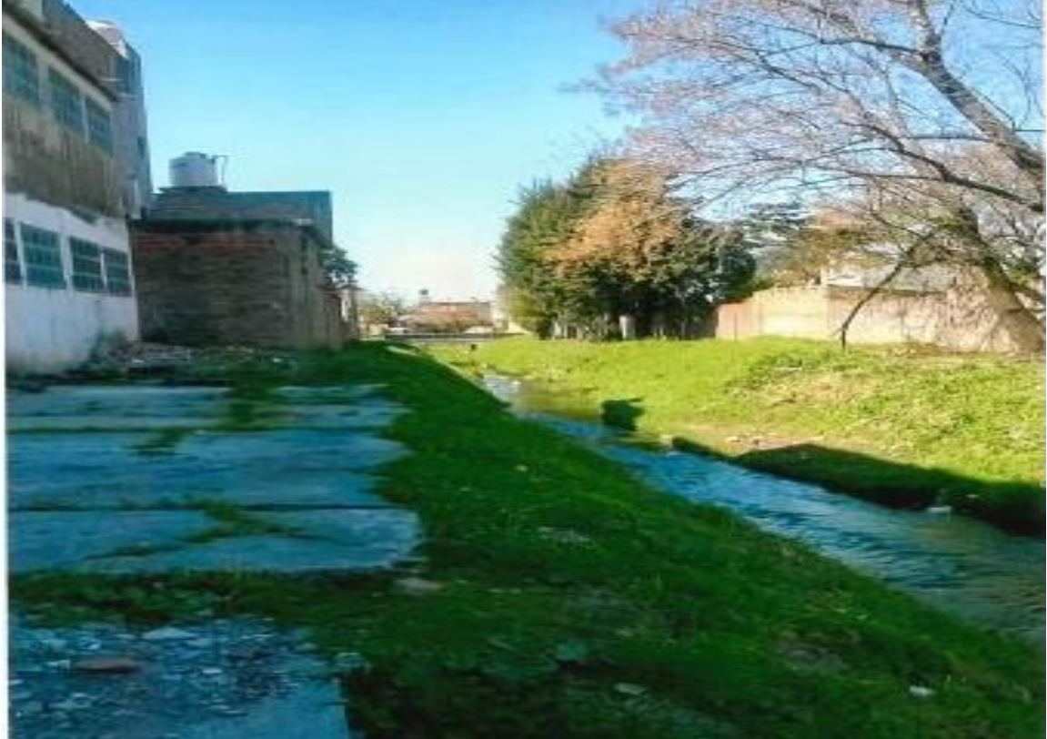
Vista de la parte posterior del edificio escolar lindera al arroyo
