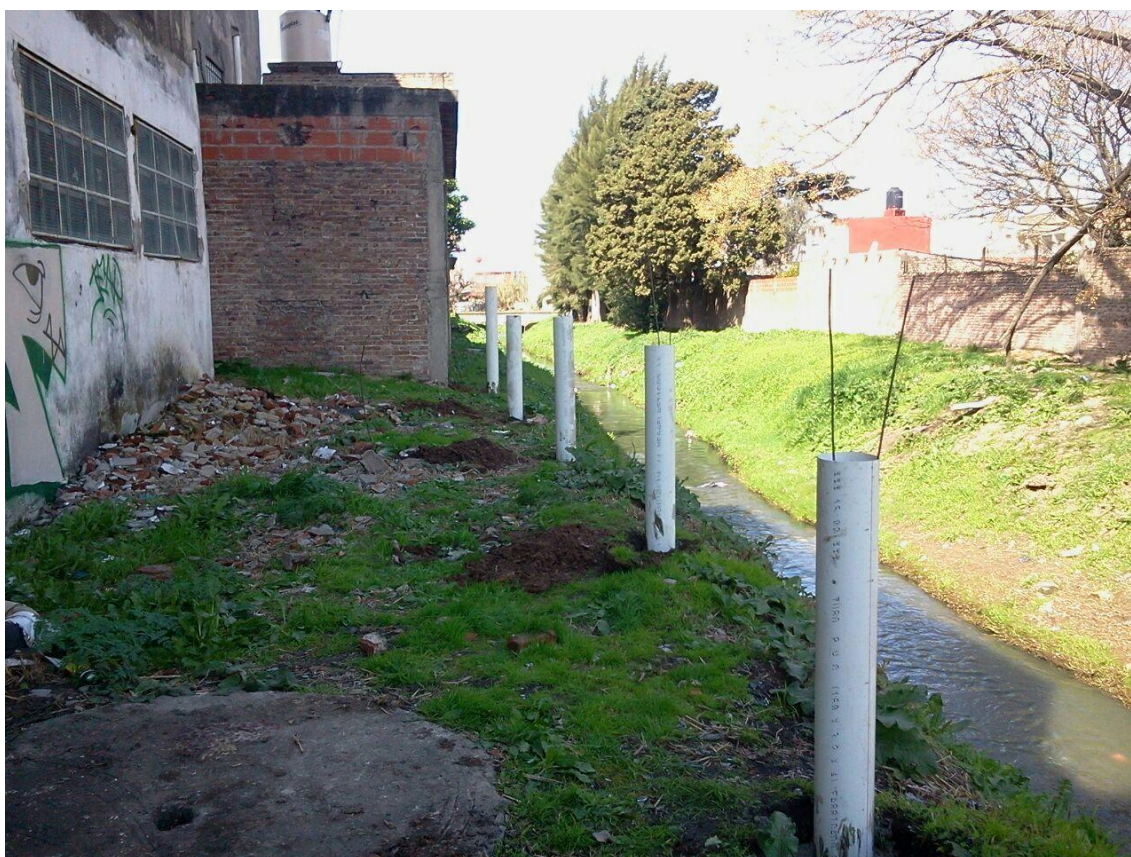
Trabajo parcialmente finalizado en la recuperación del espacio verde
