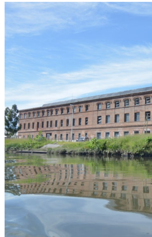
» FIG. 2.4 PATRIMONIO EDIFICIO DE LA CUENCA
