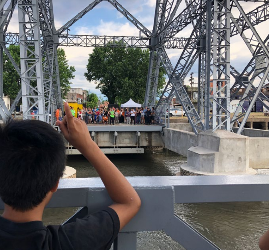
» FIG. 7.13 APERTURA ESPECIAL DEL PUENTE TRANSBORADOR PARA LOS VECINOS DE ISLA MACIEL
