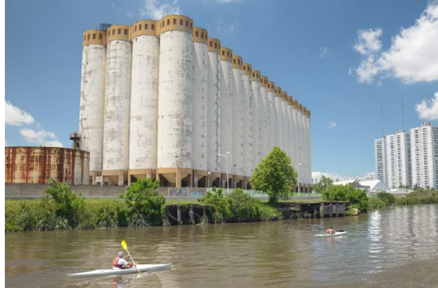
» FIG. 1.1 PATRIMONIO EDIFICIO DE LA CUENCA
