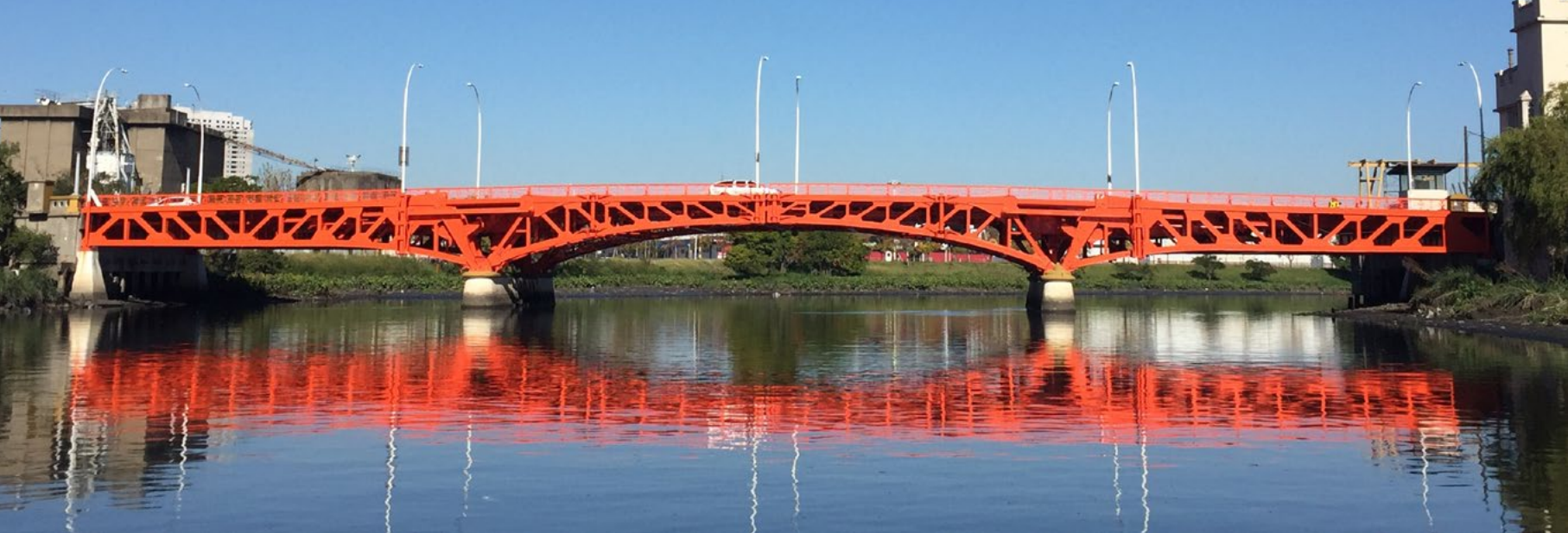
» FIG. 7.15 - 7.16 PATRIMONIO INDUSTRIAL
