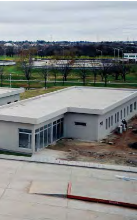
Planta El Jagüel. Terminada en 2015.
