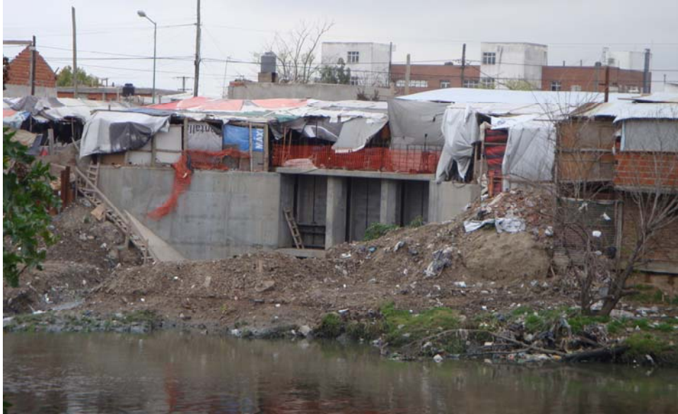
Figura II-7 . Asentamiento comercial “La Salada” en el sector inferior de la cuenca del Matanza-Riachuelo
