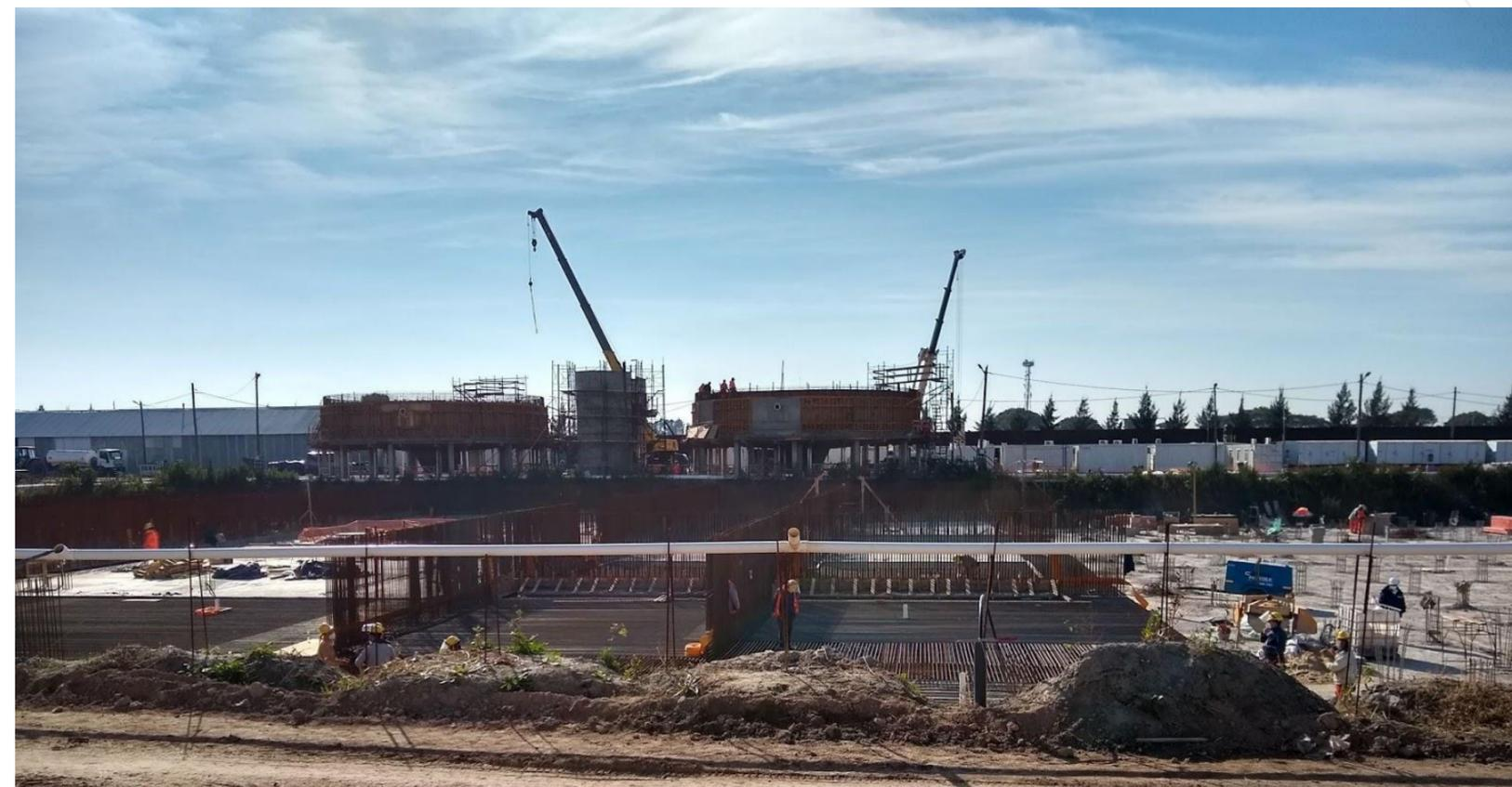
Sector de construcción de los piletones, al fondo se ve el encofrado de los sedimentadores
