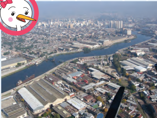
VISTA PANORÁMICA DEL RIACHUELO EN SU DESEMBOCADURA
