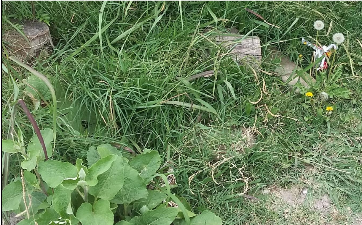
Pozo tapado por la maleza y sin dado de protección.
