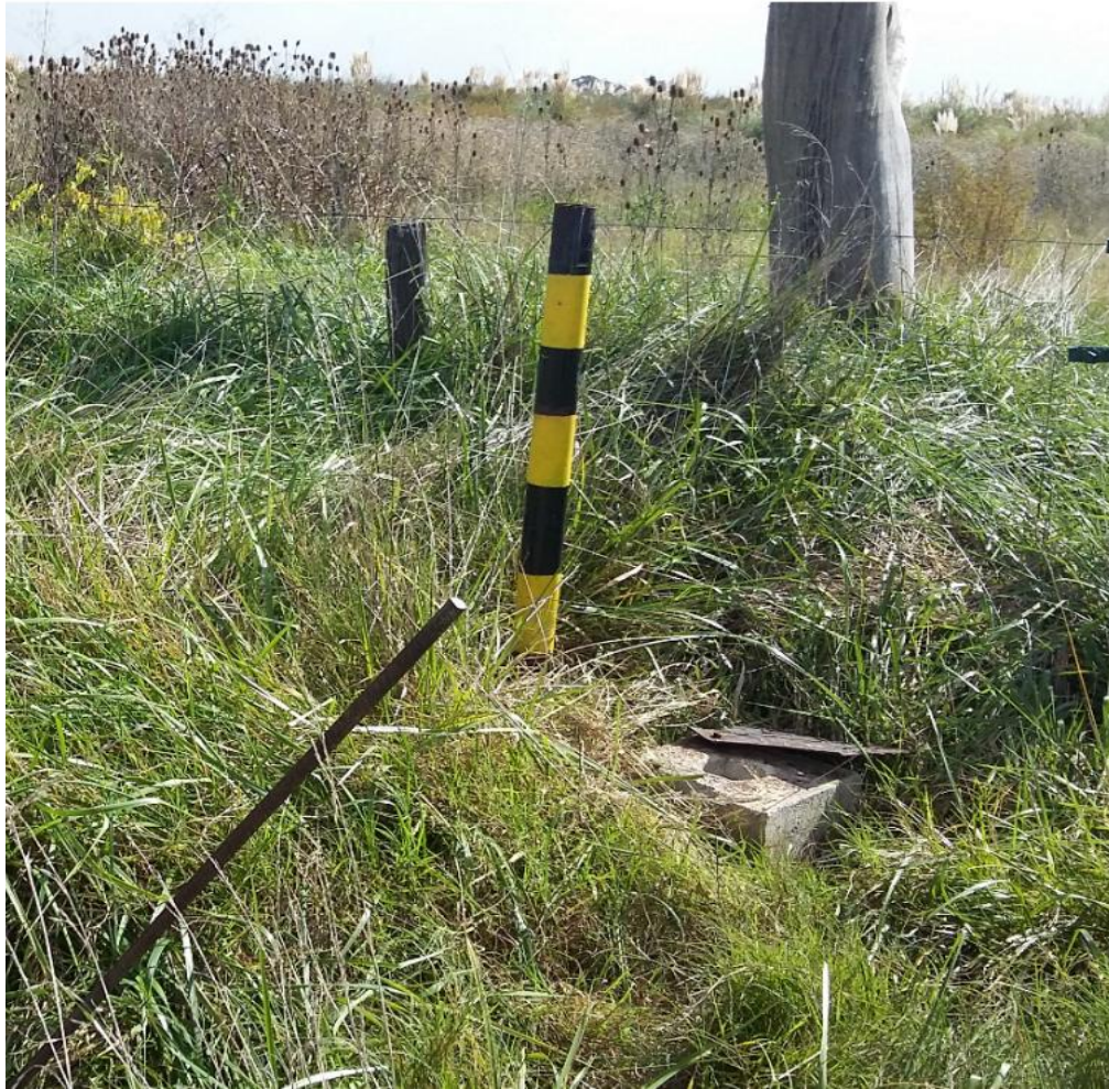
Tapa metálica suelta por corte bulones de soporte. Tapa en buen estado utilizada para pozo 1P.
