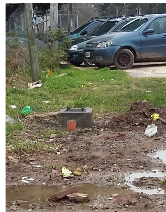
Se construyó un nuevo dado con cemento y áridos, conservando la altura original para no perder la nivelación de la boca del pozo. Se colocó la misma original y se reparó el mojón de nivelación que también fuera destruido por las obras (cañería marrón en la foto). A la izquierda estado en septiembre 2019.
