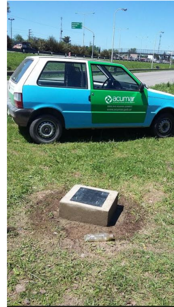
Construcción de dado de cemento nuevo y tapa metálica nueva. Septiembre 2019.
