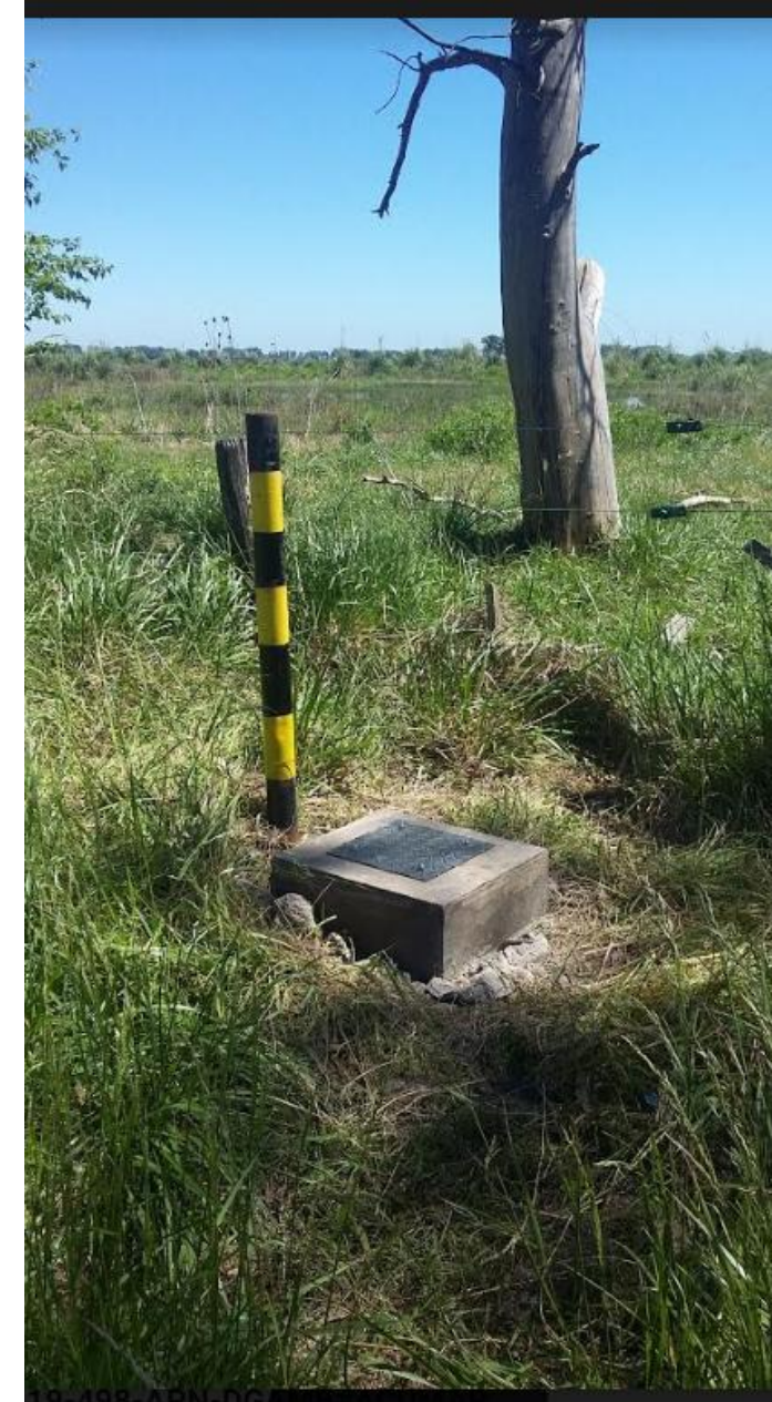
Dado de cemento nuevo, con bulones amurados al mismo. Tapa nueva. La cota se toma desde el borde de la cañería de PVC. Julio 2020.
