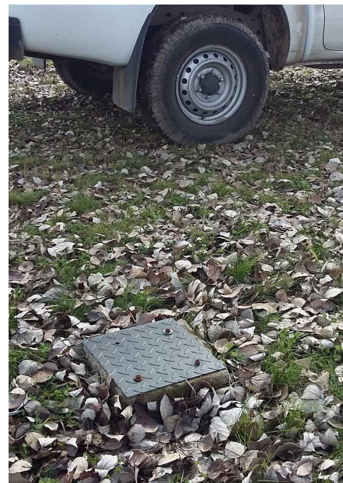
Reemplazo de tapa metálica nueva para protección del pozo. Julio 2020.
