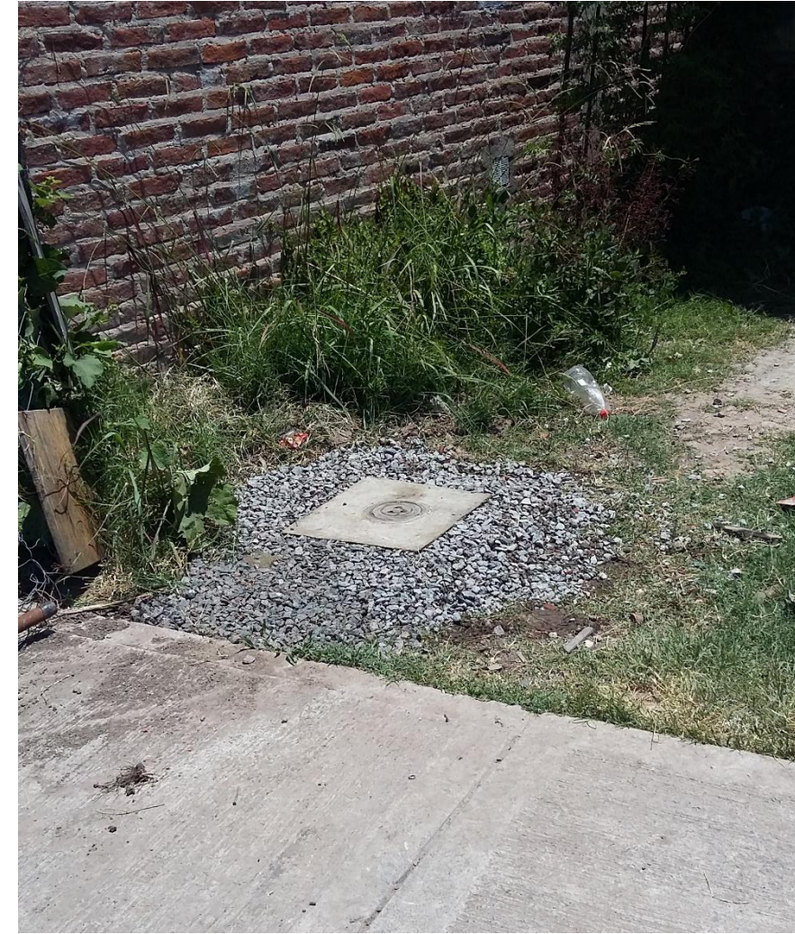
Se contruyó un nuevo dado de protección y se colocaron áridos rodeado al dado por estar ubicado en el garage de una casa de familia. Diciembre 2019.
