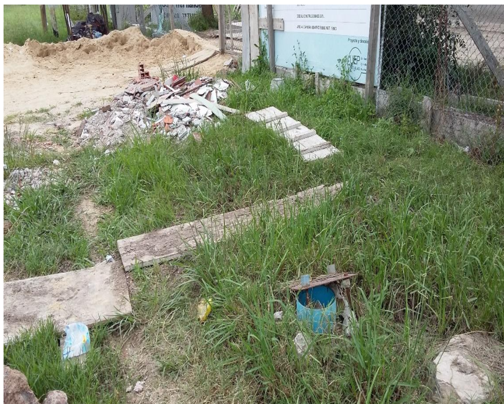
Pozo dañado por obras y maniobra de maquinaria durante la construcción de la nueva escuela. Se observa que se ha mantenido la cañería precámara del pozo y la cañería del pozo.
