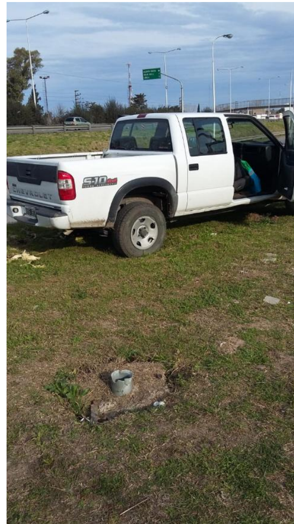
Pozo dañado por cortadora de césped. Sin dado de protección. Se encuentra obturado para impedir actos de vandalimos que dejen fuera de servicio el pozo. Se afectó la nivelación del pozo
