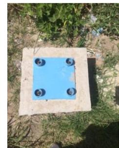
Se observan los Pozos 31F y 31P ubicados en la intersección de la calle Morse y colectora de la Autopista Bs. As.-La Plata. Los Pozos se encuentran separados una distancia de 6 m. Poseen dado de hormigón y tapa metálica. No presentan identificación.
