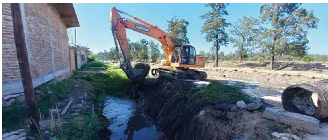
Servicio de mejora, acondicionamiento, perfilado y limpieza de cauces de agua locales para la gestión del riesgo hídrico en subcuencas de la Cuenca Matanza Riachuelo. Zanjón de la calle Ing Huergo desde la Av. De La Noria hasta Juan Díaz Solís, Esteban Echeverría.
