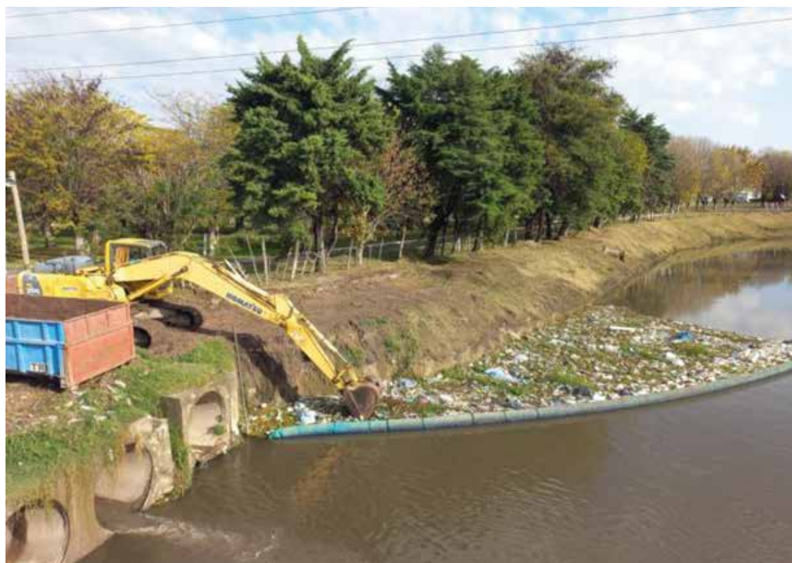
Servicio de limpieza de espejo de agua en arroyos críticos. Obrador Esteban Echeverría - Arroyo Ortega.
