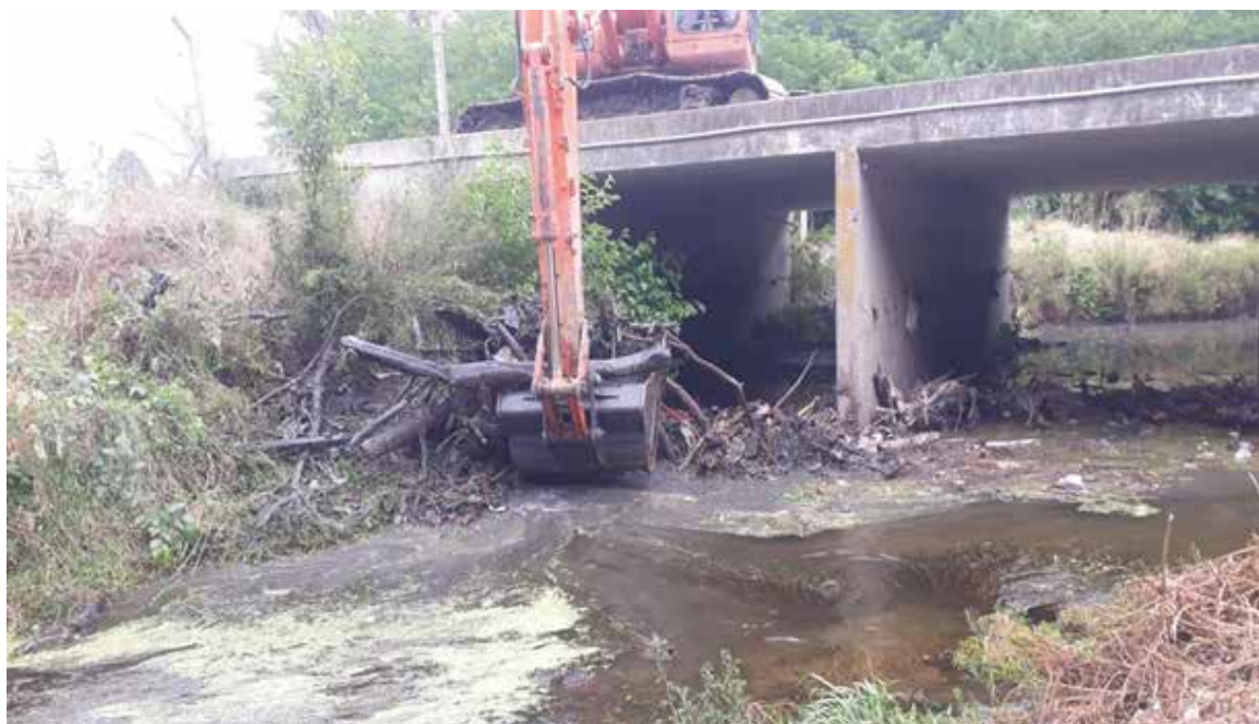
Servicio de mejora, acondicionamiento, perfilado y limpieza de cauces de agua locales para la gestión del riesgo hídrico en subcuencas de la Cuenca Matanza Riachuelo. Arroyo Aguirre y Cam. Real Presbítero Gonzáles y Aragón, Ezeiza.
