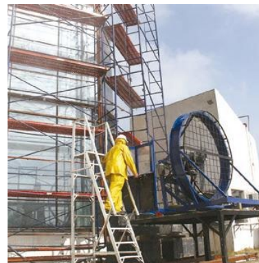
Cámara de ensayos de muros cortinas
