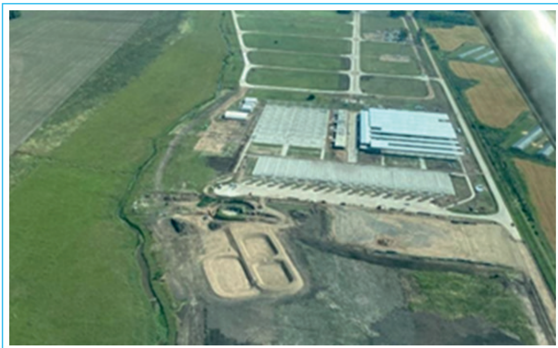
Imagen 1: vista aérea de MAG en etapa constructiva
