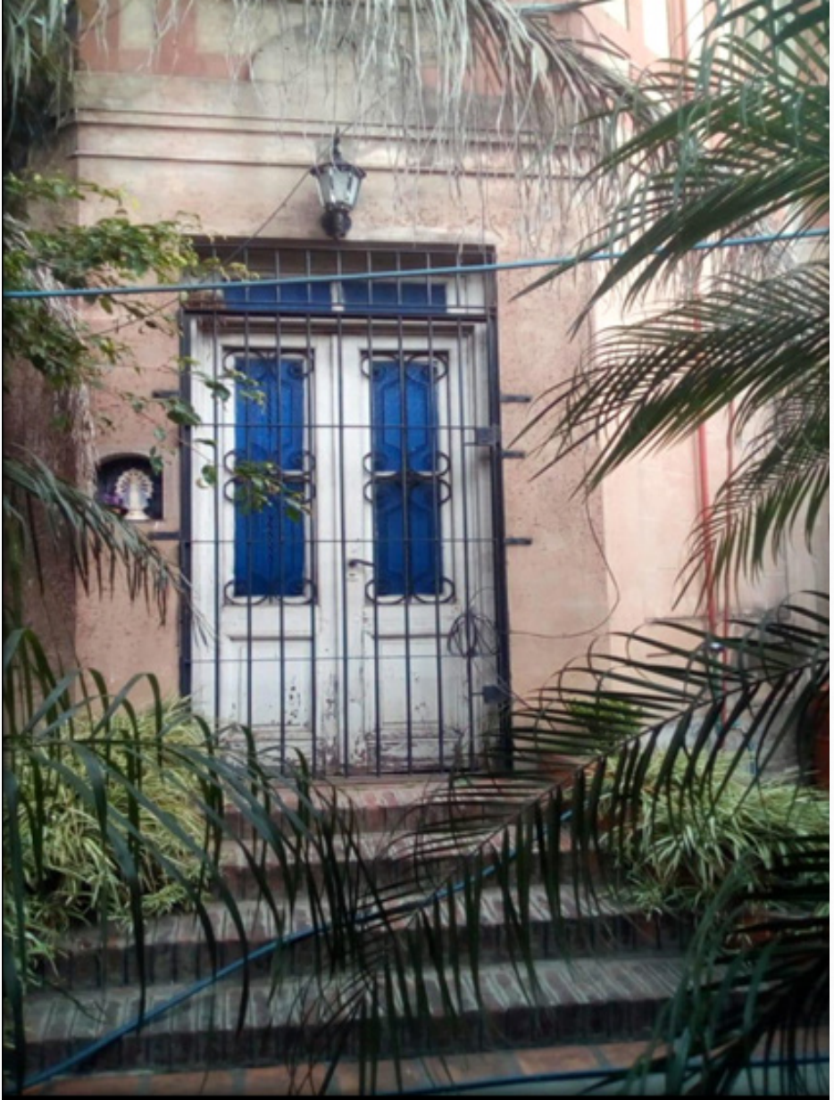
Entrada principal del chalet de Andrade 6072. Los chalets tenían dos entradas a la casa. La vegetación es original. Pueden verse los escalones, ya que fue construido en terreno sobrelevado para evitar posibles anegaciones.
