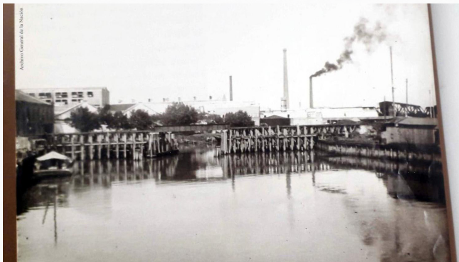
Puente sobre el Riachuelo. Archivo General de la Nación
