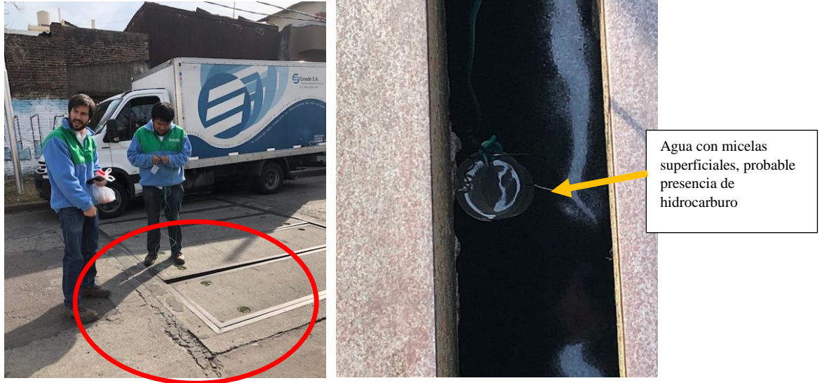
Foto 1. Tapa de agua (entubamiento arroyo Aguirre-San Martín) con eliminación de olor característico de hidrocarburos.
