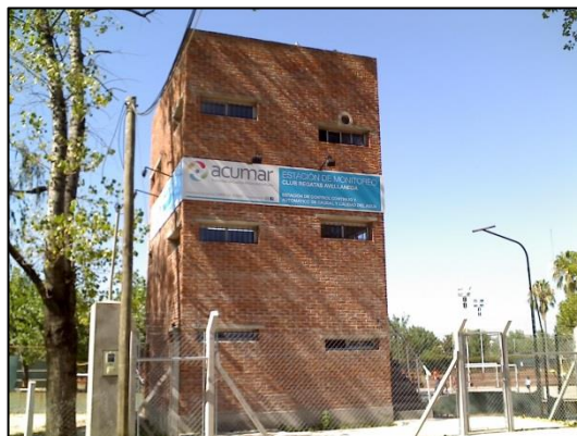
Figura 1.9. Estación de Control Continuo y Automático de Caudal y Calidad del Agua, Regatas Avellaneda.
