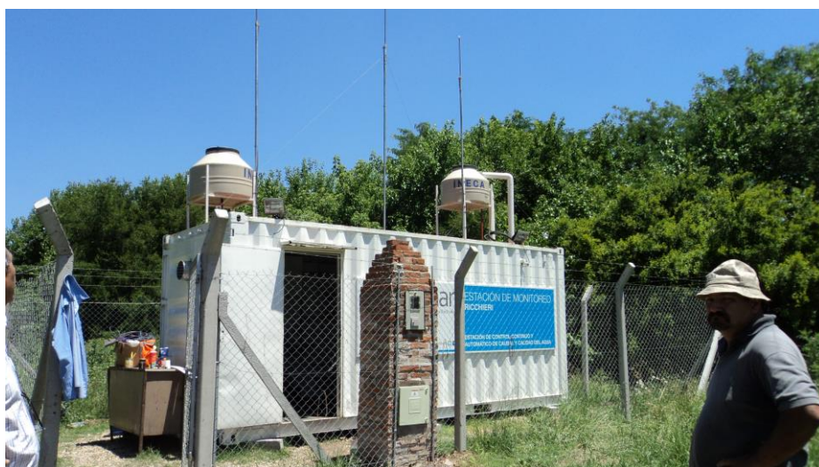
Figura 1.14. Estación de Monitoreo y Control Continuo Ricchieri.
