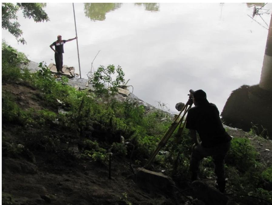
**Figura 6.4.** Nivelación para sondeos de caracterización de sedimentos. Obtención de cota IGN del espejo de agua.
