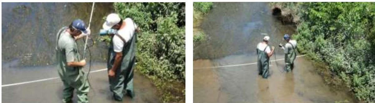
**Figura 1.10 y 1.11.** Medición de Velocidad del curso de agua para determinación de Caudales en la Cuenca Matanza Riachuelo realizada por EVARSA.
