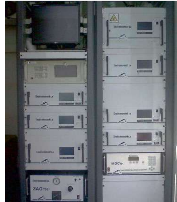
Imagen externa e interna de la Estación de Monitoreo Continuo EMC I emplazada en Dock Sud
