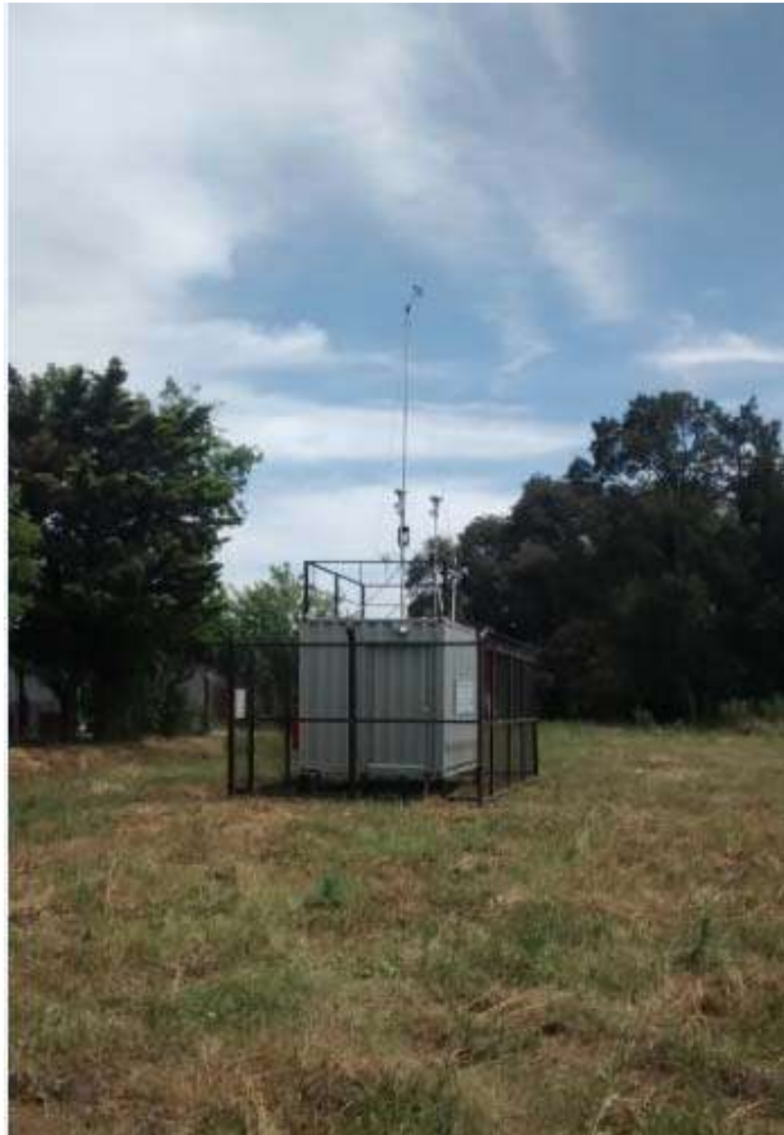
Imagen 4.2 Imagen de la Estación de Monitoreo Continuo EMC II emplazada en La Matanza.
