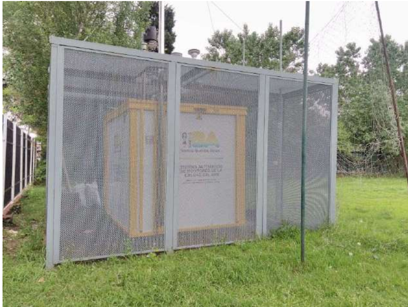
Figura 3. Estación La Boca
