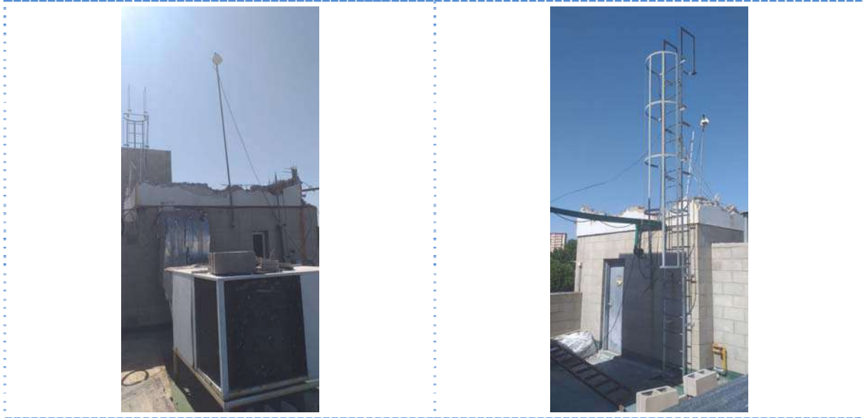
Imágenes 3.4.1 a 3.4.6 Vista de las tareas de demolición de la ex estructura de soporte del receptor del OP1.
