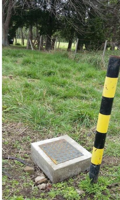
Figura 3.1.1. Reparación de dado de protección y reposición tapa metálica. Pozo 4F, Marcos Paz.
