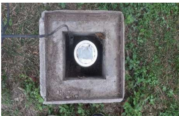
Figura 3.1.2. pozo 37P, vandalizado, sin tapa
