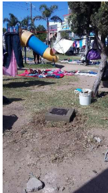
Figura 4.1.4. Pozo 13P, previo a la reparación. Figura 4.1.5. Luego de reforzar el dado de protección.
