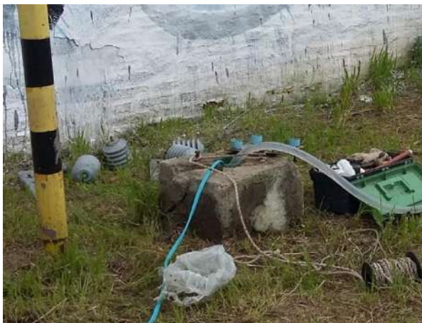
Figura 4.1.6. Estado previo ante de reparar.
