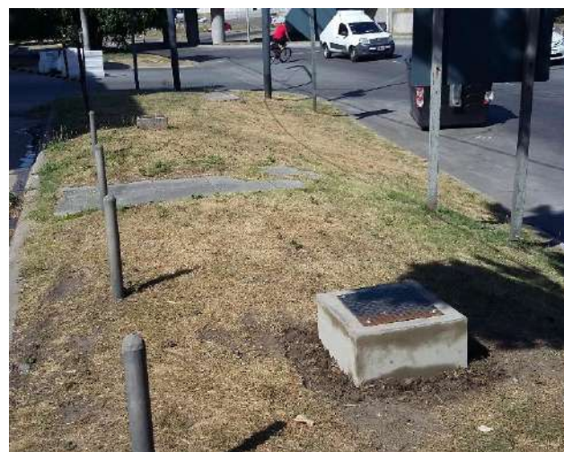
Figura 3.1.3. Con reparación finalizada.
