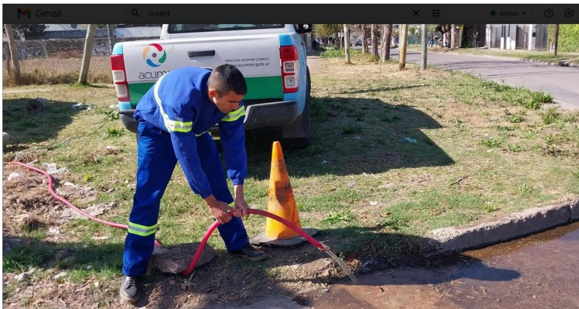
**Figura 3.1.4.** Purgado del piezómetro para verificar el funcionamiento.
