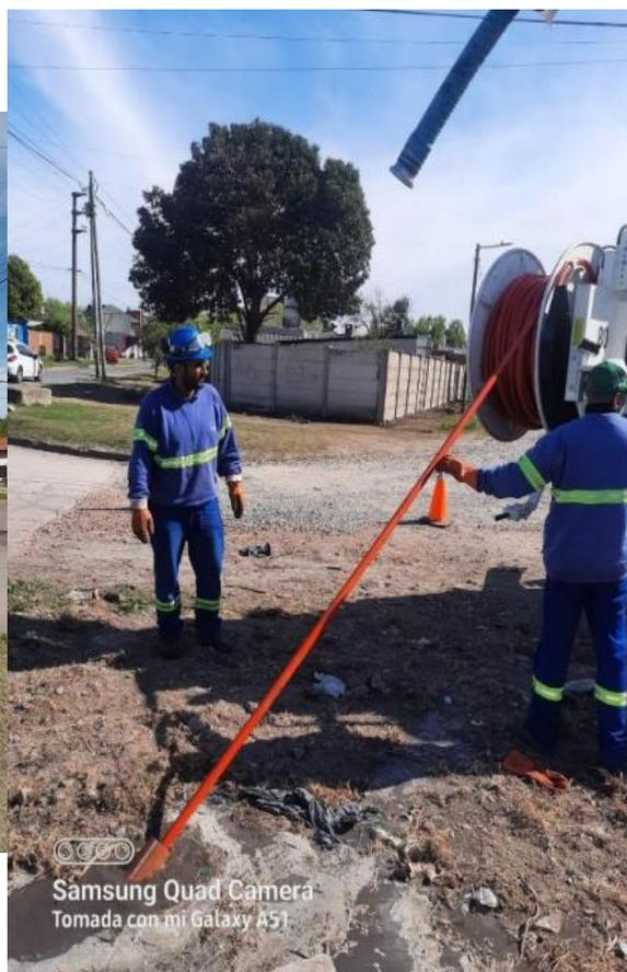
**Figura 3.1.3.** Equipo de AySA en tareas de inyección de agua en el piezómetro AB-715.
