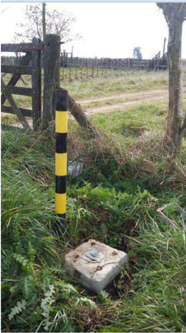
Dado roto por maquinaria vial. Tapa suelta por falta de bulones de fijación.
