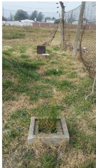
**Figura 3.1.5.** Pozos 35P (en primer plano) y 35F (al fondo) en el estado previo a las reparaciones.
