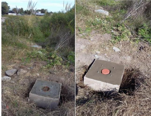
**Figura 3.1.8.** Distintas etapas de las tareas de reparación del freatímetro VIF-08.
