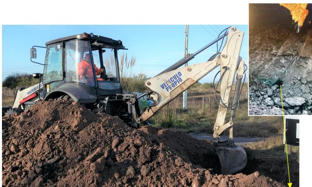
**Figura 3.1.3.** Destape del pozo mediante uso de retro pala.
