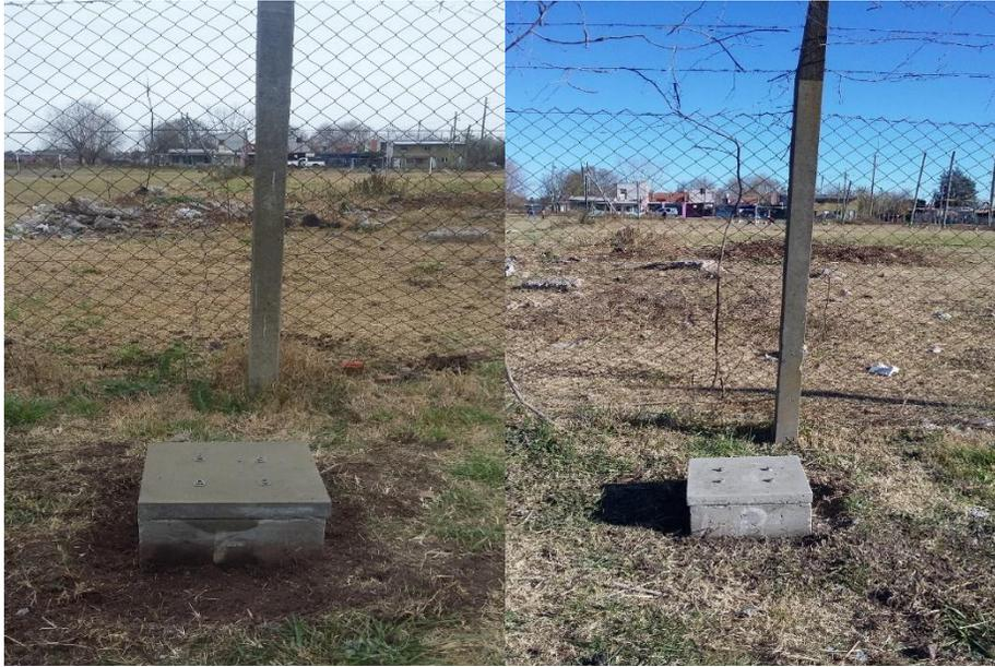
Se reconstruyó la estructura superficial del pozo (dado de protección) para dar mayor rigidez al mismo y se construyeron tapas de cemento para evitar robos y vandalismo.
