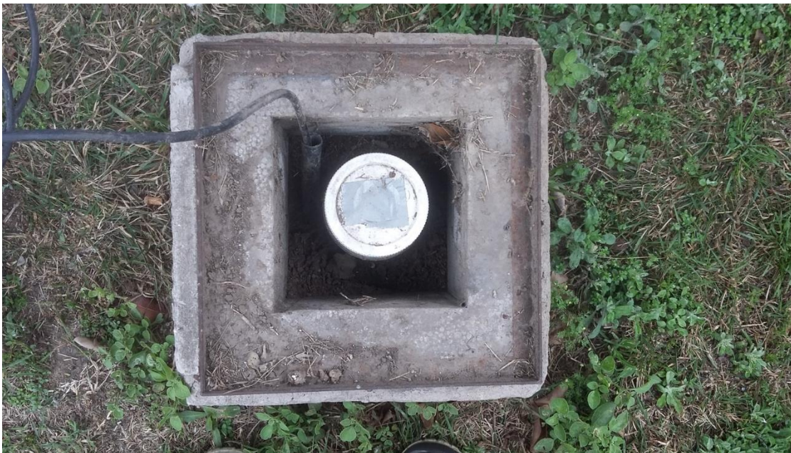
Figura 4.1.1. Piezómetro 37P. Dañado con pérdida de tapa metálica y corte de cable del sensor.
