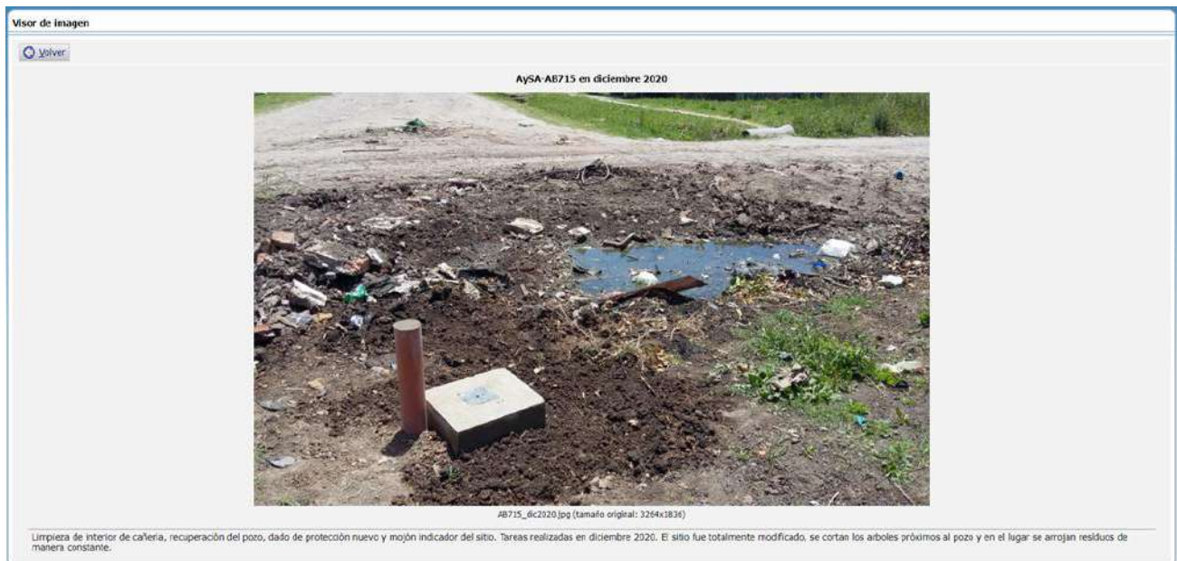
Figura 1.3.3. Vista de uno de los pozos de monitoreo reparado y descripción de su entorno.
