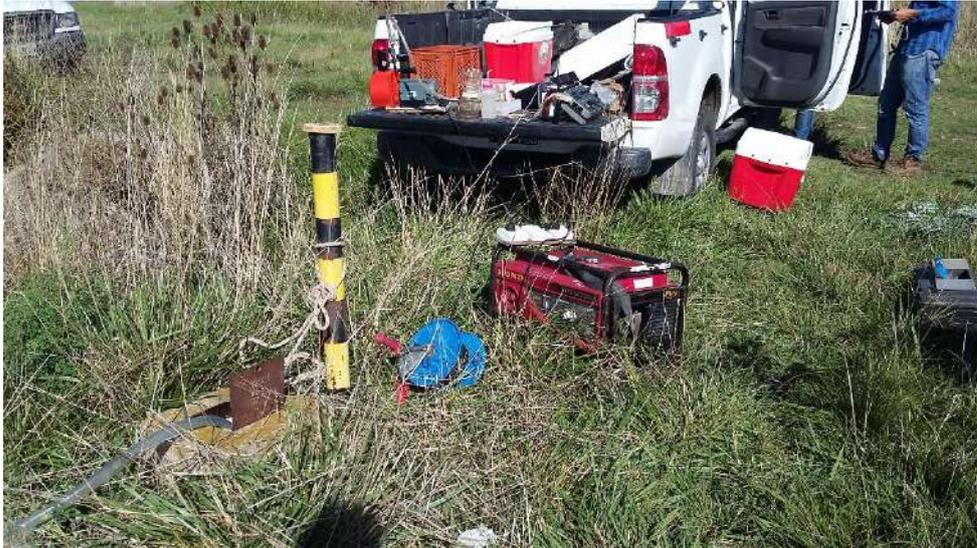
**Figura 3.3.** Bombeo para purgado de pozo durante la toma de muestras.
