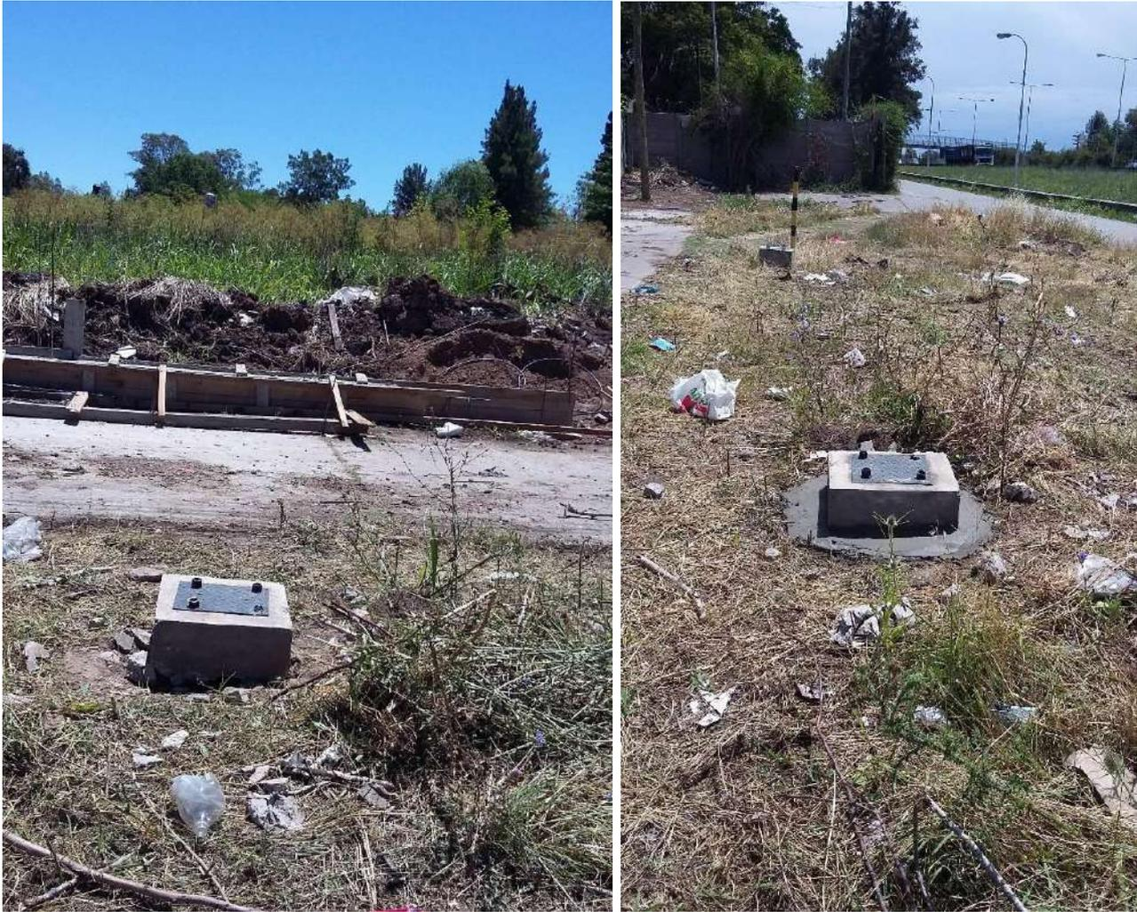
**Figura 3.1.1.** Reparación de pozo 16F afectado por obras, Virrey del Pino, La Matanza.
