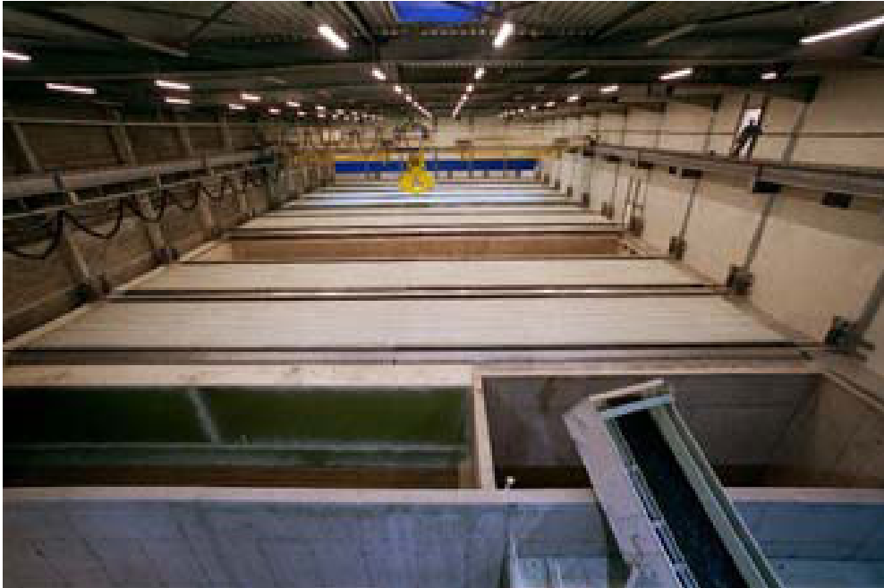
Ilustración 13 - Sistema de carga y descarga de los contenedores de descomposición (boxes)
