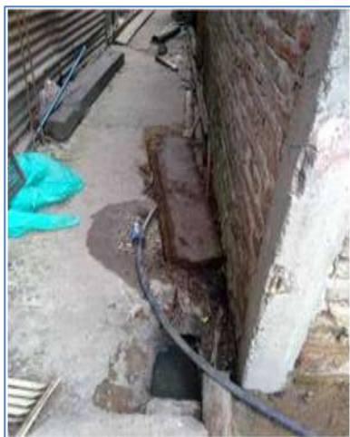
Figura 7. Agua para consumo y pozo negro en mismo punto. Entrada a viviendas.
