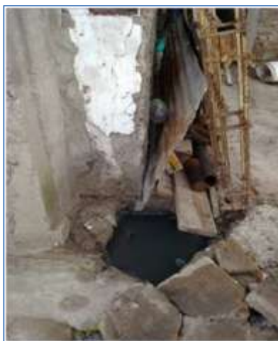
Figura 7. Agua para consumo y pozo negro en mismo punto. Entrada a viviendas.
