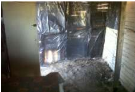
Piso tierra y escombros
