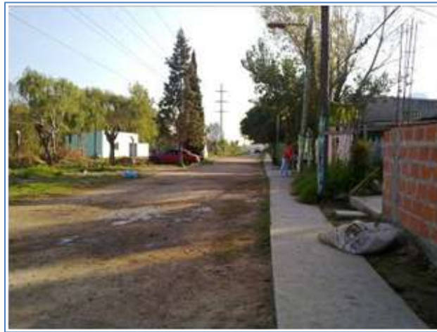
Figura 10. Vereda con y sin cordón en un sector calle Génova.
