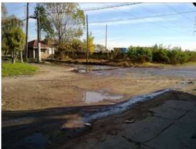
Figura 8. Anegamientos en vía pública. Falta de mantenimiento de la infraestructura en calles de circulación vehículos pesados. Esquina Morse y Ocantos.
