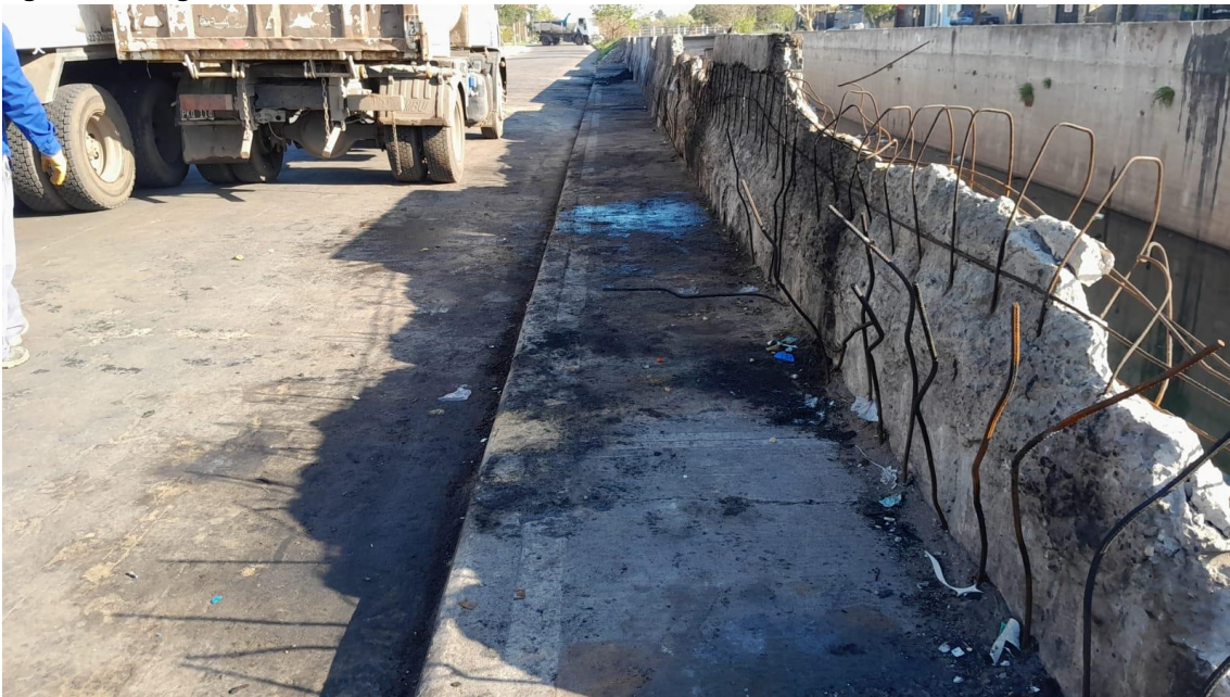
Figura 4. Acciones de limpieza de ACUMAR en calles laterales del arroyo del Rey. Sta. Marta, Ingeniero Budge, Lomas de Zamora.
