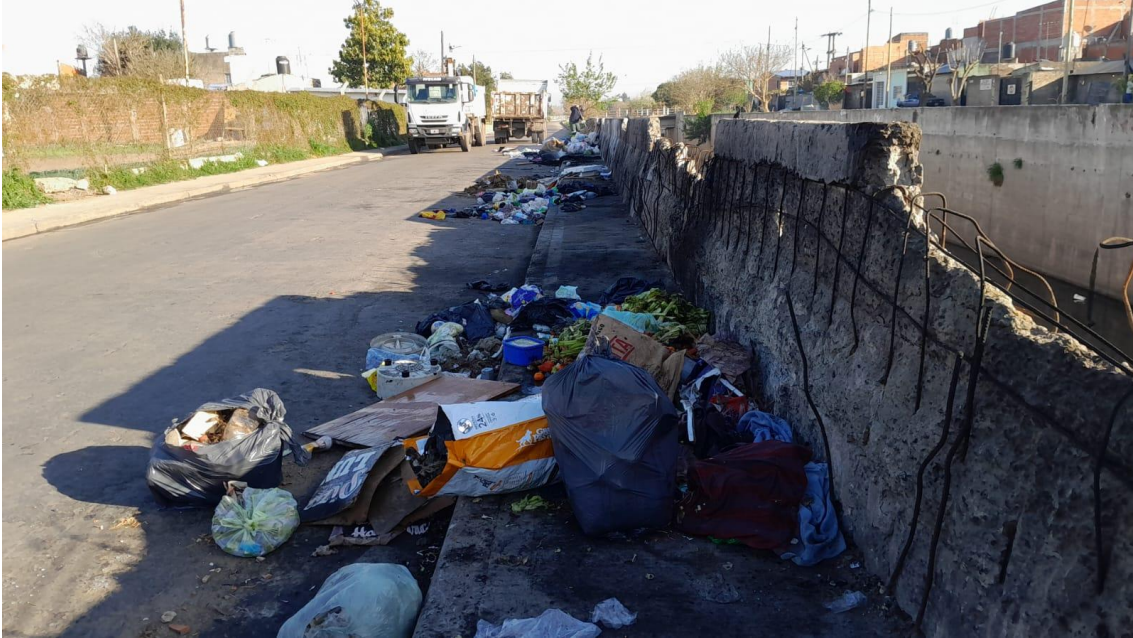
Figura 3. Acciones de limpieza de ACUMAR en calles laterales del arroyo del Rey. Sta. Marta, Ingeniero Budge, Lomas de Zamora.
