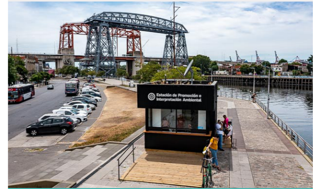
El diseño de las estaciones incluye arquitectura bioclimática : techos verdes con flora autóctona, recuperación del agua de lluvia para riego y paneles solares.
