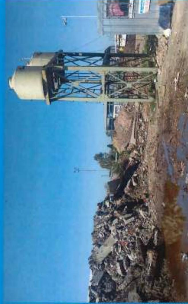
Trituradora de escombros y material obtenido a partir del proceso de trituración. Del lado derecho, residuos a ser removidos.
