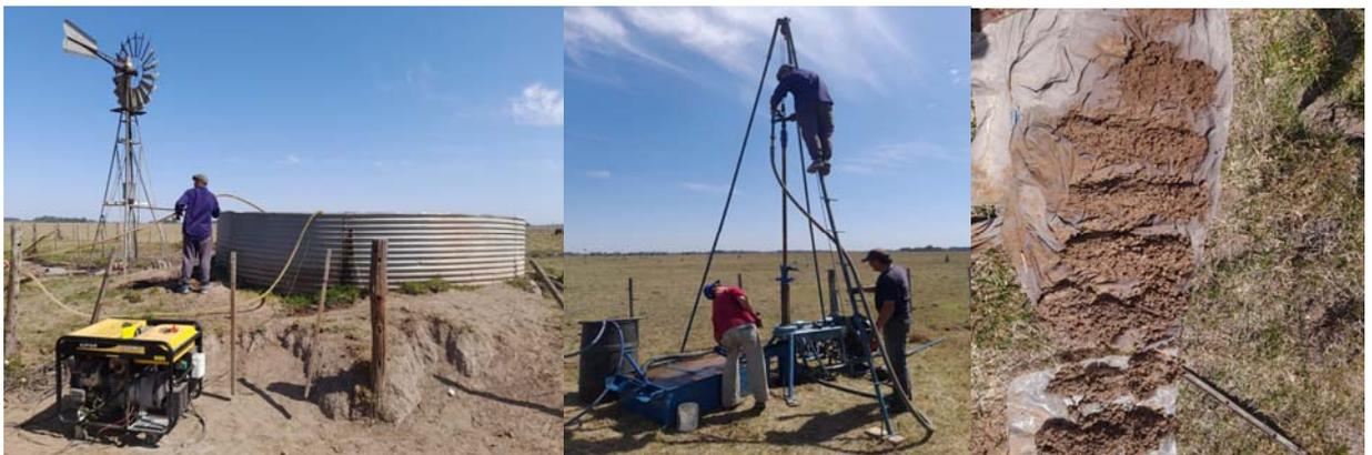
**Imagen 8.** Pozo freatímetro 02, trabajos de perforación y toma de muestras de suelo (11/10/2022).
