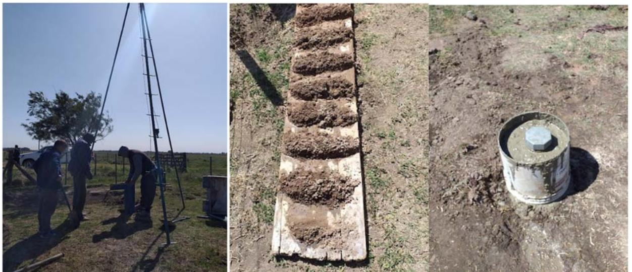
**Imagen 10.** Trabajos de perforación de pozos correspondiente al freático 04, toma de muestras de suelo y terminación en cemento de la protección del freático (13/10/2022).
