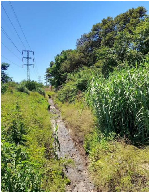
Imagen 6. Tramo rectificado del arroyo sin nombre en la parcela 1191 B, sin agua.
