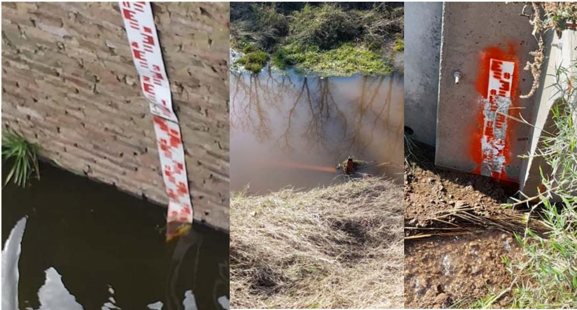
**Figura 3.** Detalle de escalas deterioradas.
