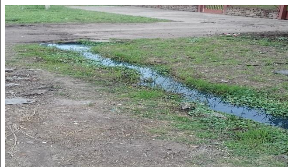
Foto 8: Aguas servidas en la vía pública
