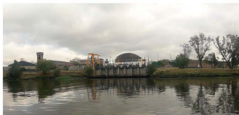
DESPUÉS: 23 de febrero de 2023 Vista desde: margen de enfrente (Avellaneda)
