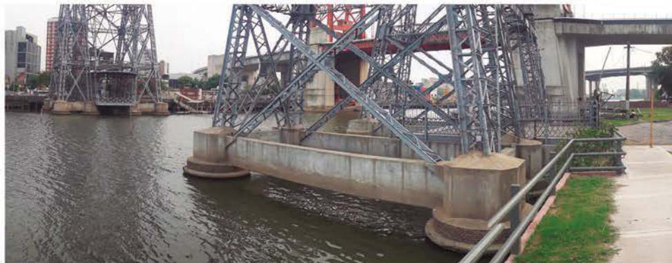
DESPUÉS: 14 de febrero de 2023 Vista desde: Camino de Sirga hacia Desembocadura
