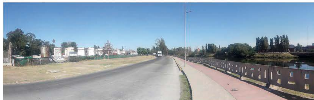
DESPUÉS: 22 de febrero de 2023 Vista desde: Camino de Sirga hacia Cuenca Alta
