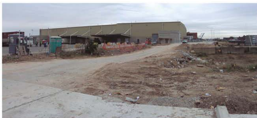
ANTES: 14 de julio de 2011 Vista desde: Camino de Sirga hacia Cuenca Alta
