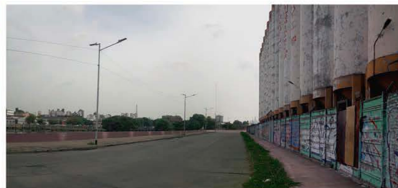
DESPUÉS: 14 de febrero de 2023 Vista desde: Camino de Sirga hacia Desembocadura
