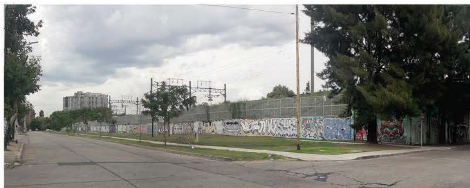
DESPUÉS: 16 de febrero de 2023 Vista desde: Camino de Sirga hacia el Municipio de Avellaneda
