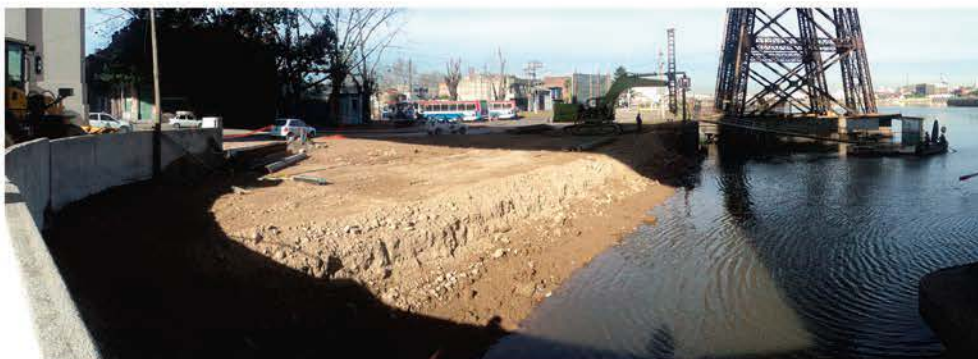
ANTES: 12 de julio de 2012 Vista desde: Camino de Sirga hacia Cuenca Alta
