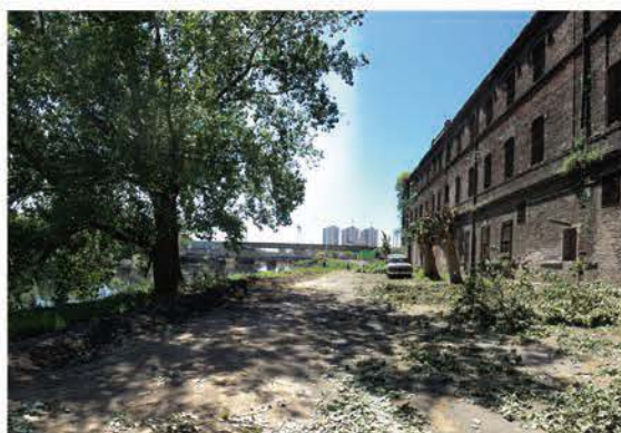
Vista desde: Camino de Sirga hacia Desembocadura
