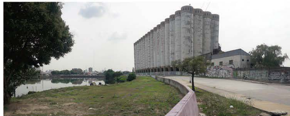
DESPUÉS: 14 de febrero de 2023 Vista desde: Camino de Sirga hacia Desembocadura
