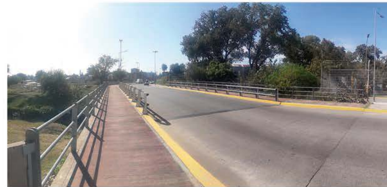
DESPUÉS: 22 de febrero de 2023 Vista desde: Camino de Sirga hacia Desembocadura
