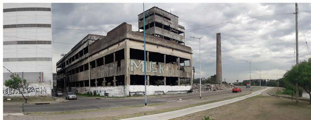
DESPUÉS: 16 de febrero de 2023 Vista desde: Camino de Sirga hacia Cuenca Alta
