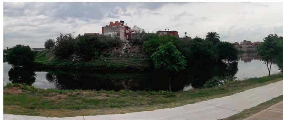
DESPUÉS: 16 de febrero de 2023 Vista desde: margen de enfrente (Avellaneda)
