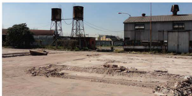
Archivo: Septiembre de 2011 Vista desde: el interior del predio - Tareas de nivelación del terreno
