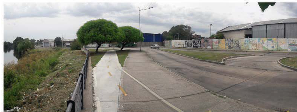
DESPUÉS: 16 de febrero de 2023 Vista desde: Camino de Sirga hacia Desembocadura
