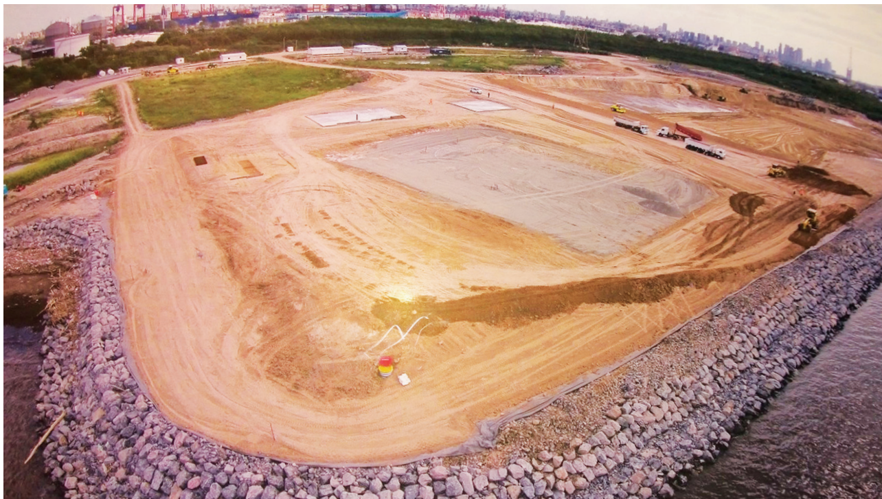
Terreno a orillas del Río de la Plata en Dock Sud donde se construirá la planta de tratamiento.
