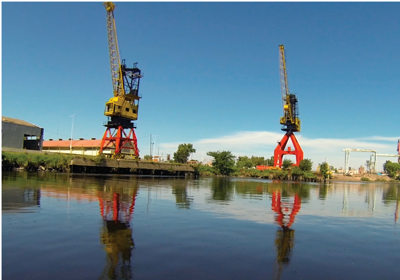
Grúas del puerto recuperadas por ACUMAR, Avellaneda.
