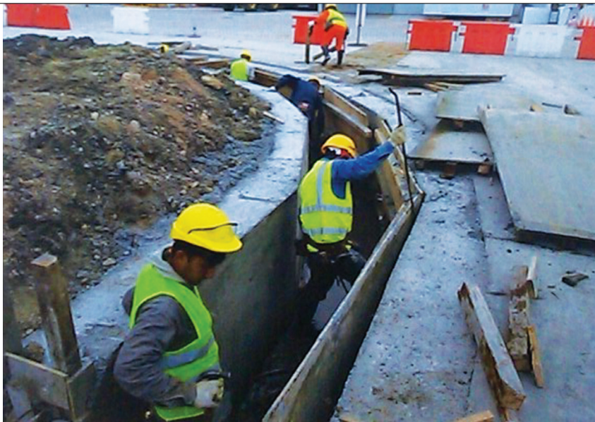
Obras de construcción de Colector Margen Izquierdo.
